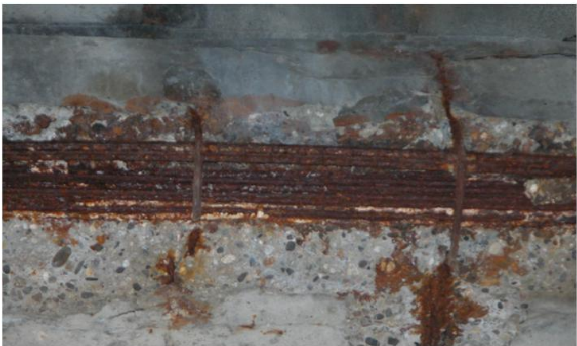
Figura 13. Probabile corrosione interna ad un cavo di precompressione.
