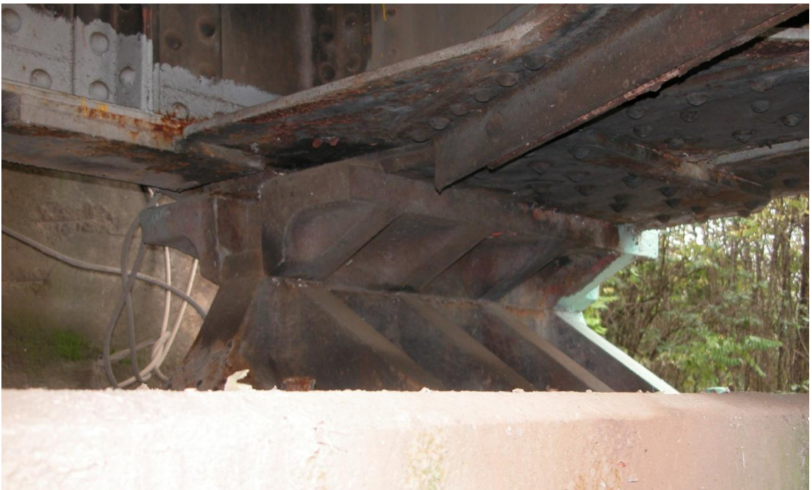
Figura 8. Particolare del meccanismo della cerniera di appoggio.
