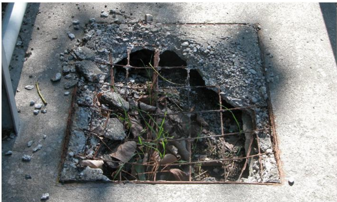
Figura 12. Botole disposte lungo il camminamento rovinate.
