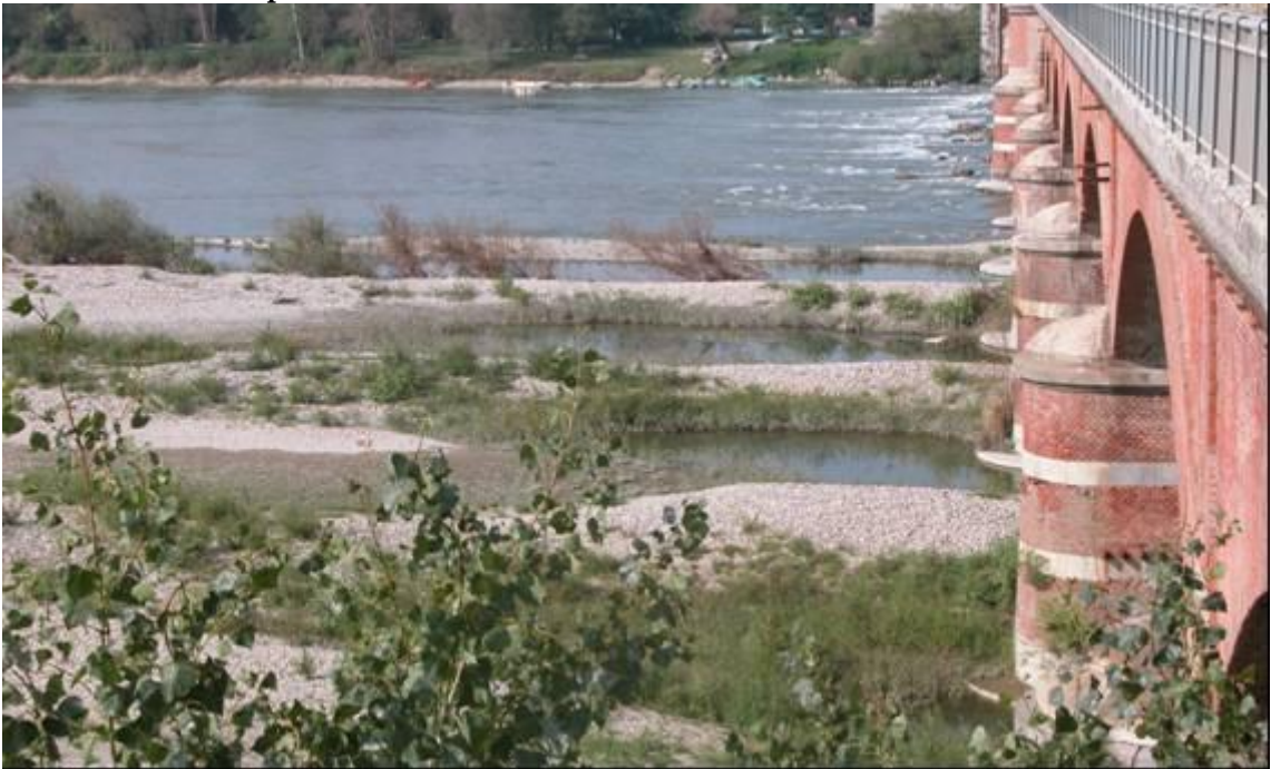
Figura 8 - Vista del fiume lato monte. Si noti la modesta presenza di ramaglie fermate dalle pile e l'erosione attorno ad esse visibile nella zona in secca.
