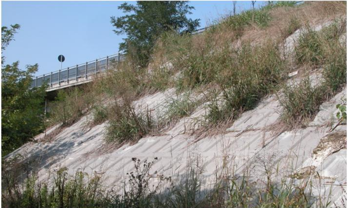
Figura 5. Spalla del ponte costituita da terreno rinforzato.
