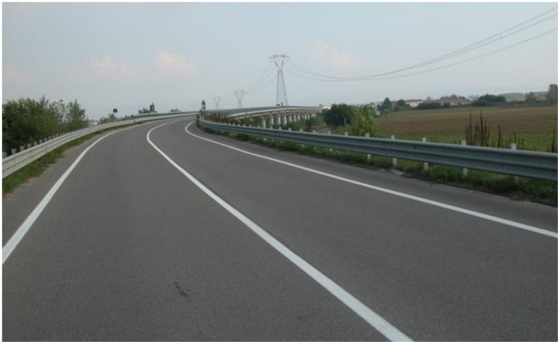
Figura 13. Viadotto di accesso al ponte, vista dalla strada.
