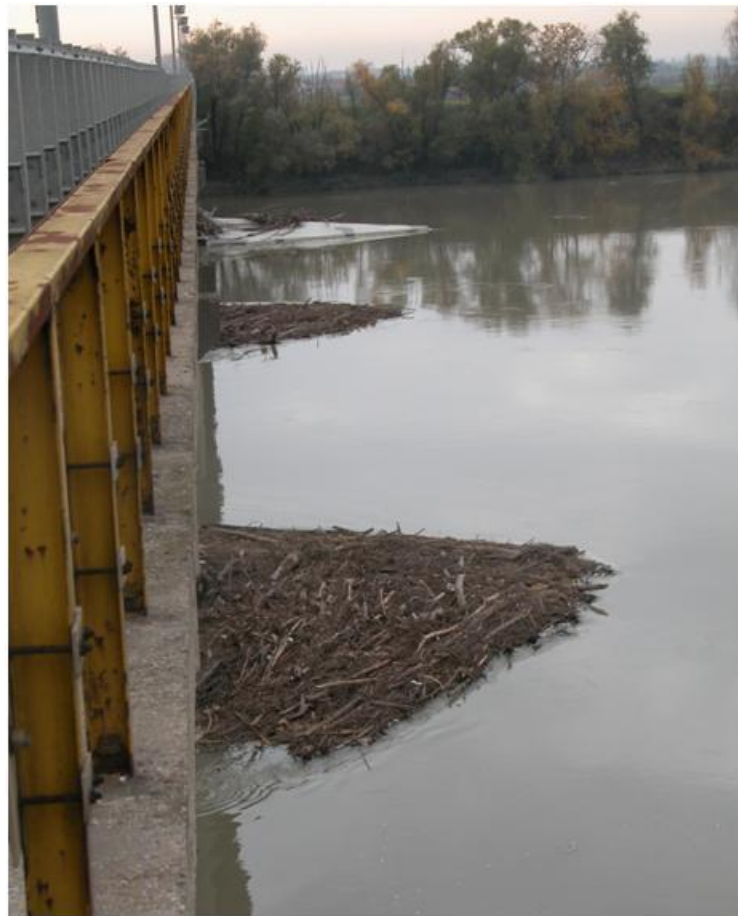
Figura 6. Struttura di protezione delle pile.
