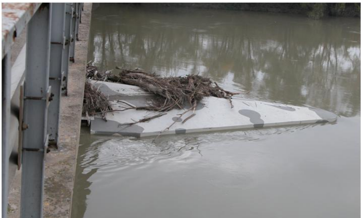
Figura 6. Struttura di protezione delle pile.
