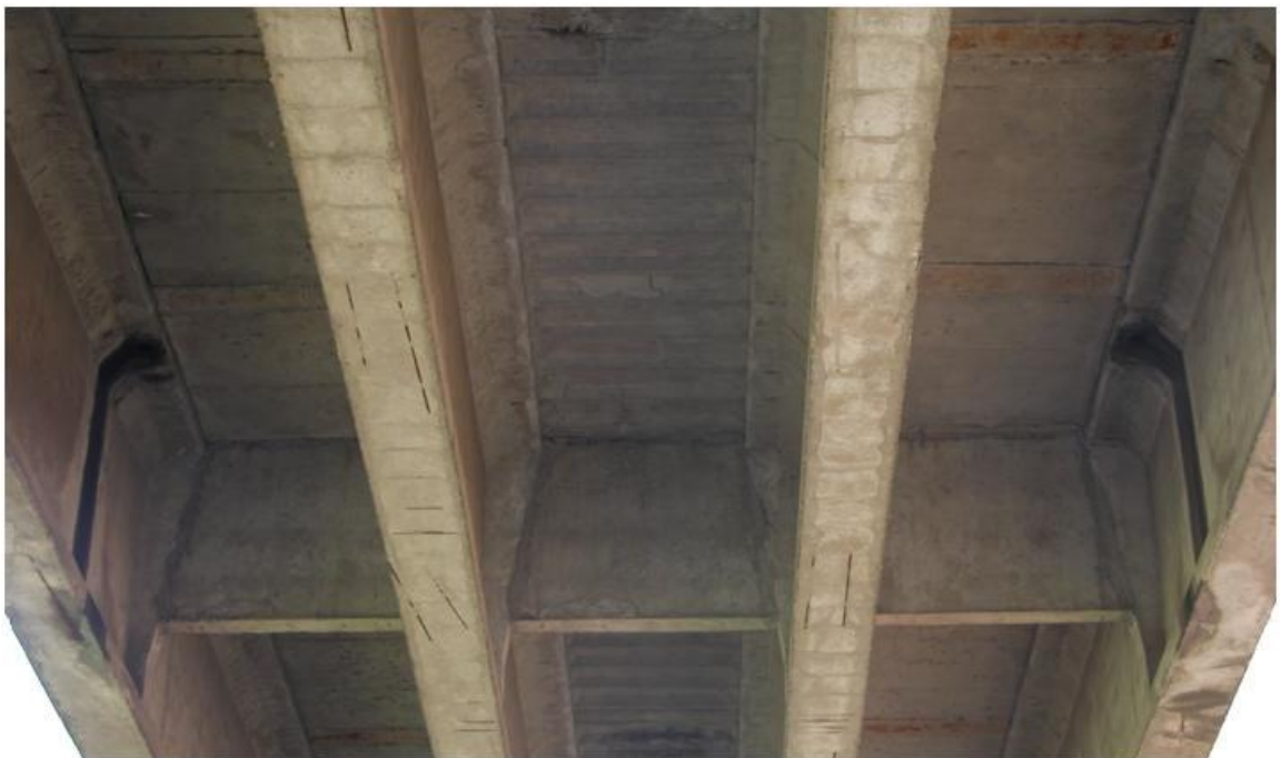
Figura 9. Totale mancanza di pluviali.
