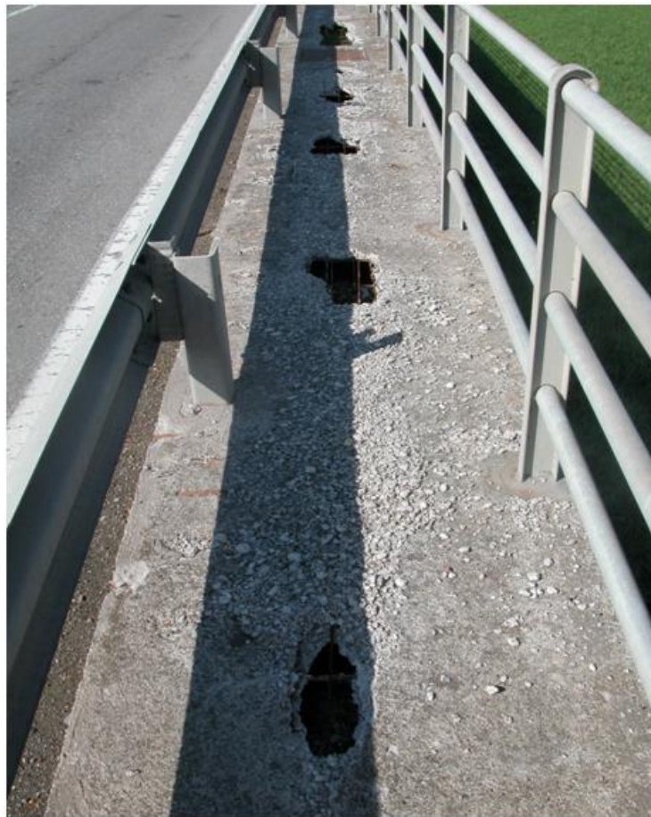
Figura 12. Botole disposte lungo il camminamento rovinate.
