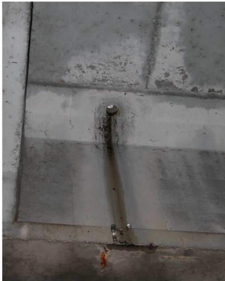
Figura 12. Mancanza del tubo di scolo dell'acqua piovana.
