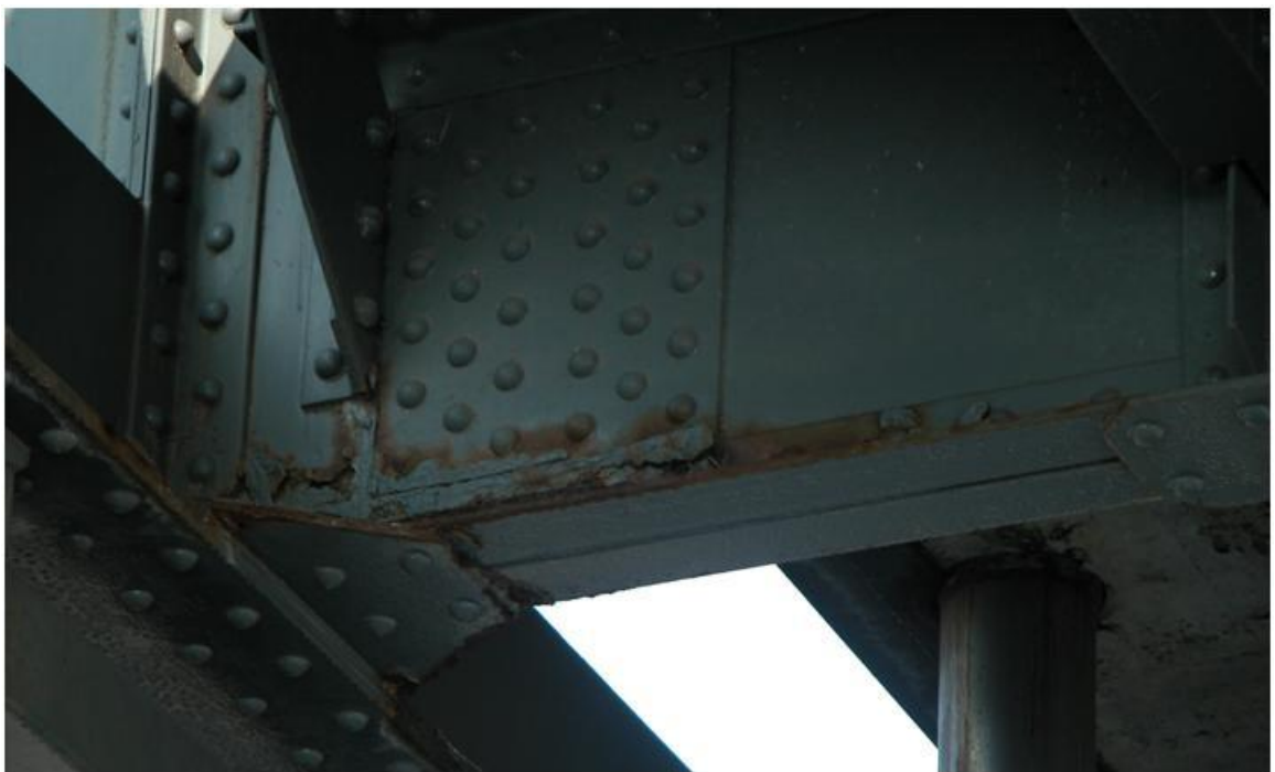
Figura 10. Scrostamento della vernice e corrosione dell'elemento.
