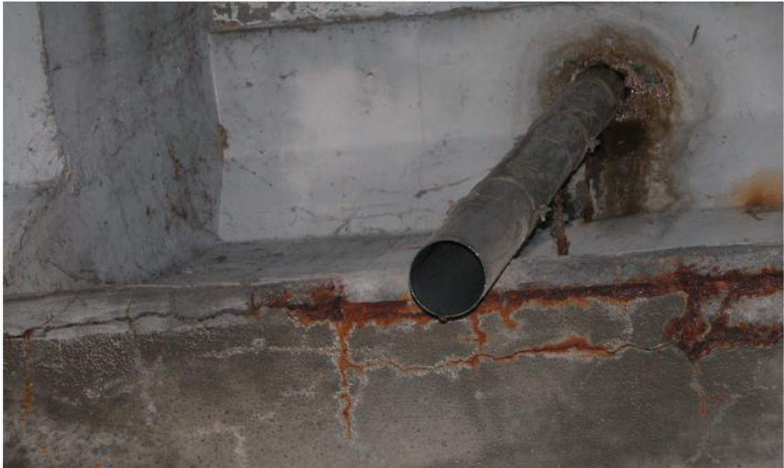
Figura 12. Mancanza del tubo di scolo dell'acqua piovana.
