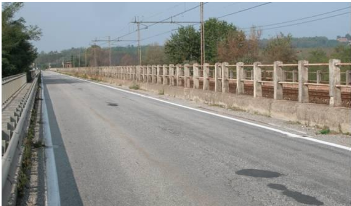
Figura 5 - Strada SS494 lato valle, linea ferroviaria lato monte.
