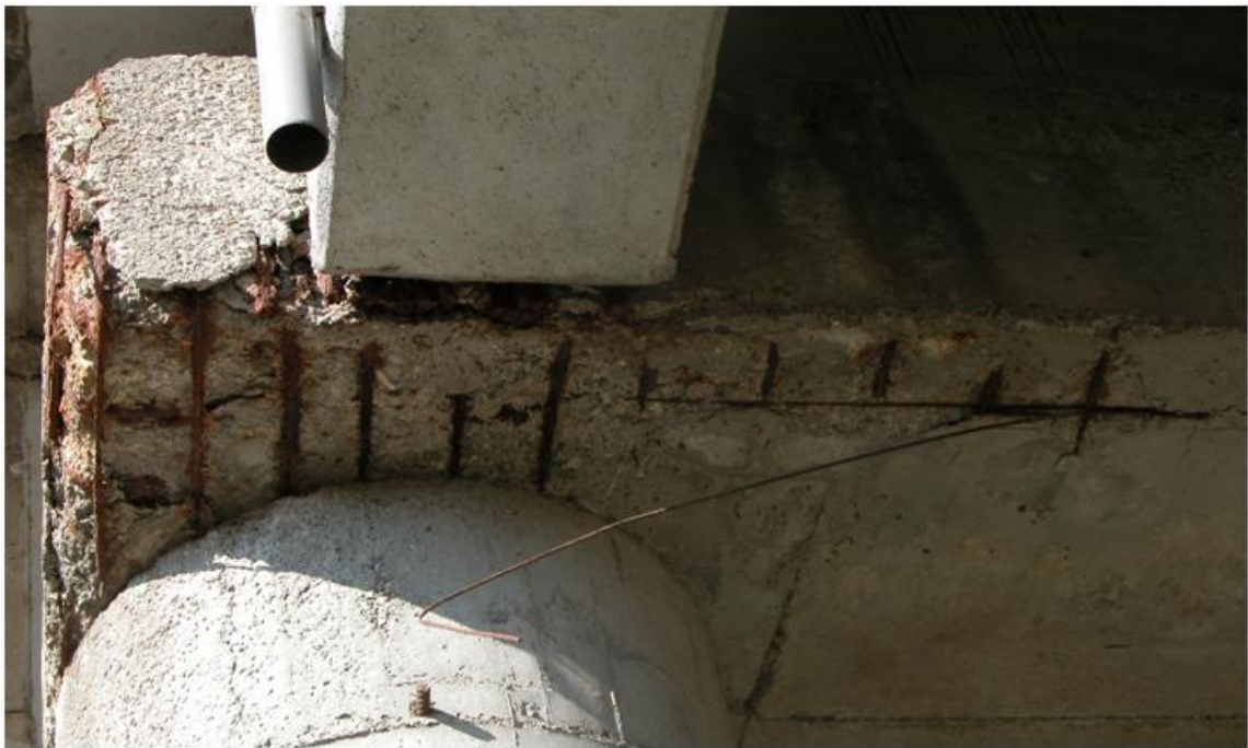
Figura 16. Travi rinforzate con l'applicazione di piastre in acciaio.
