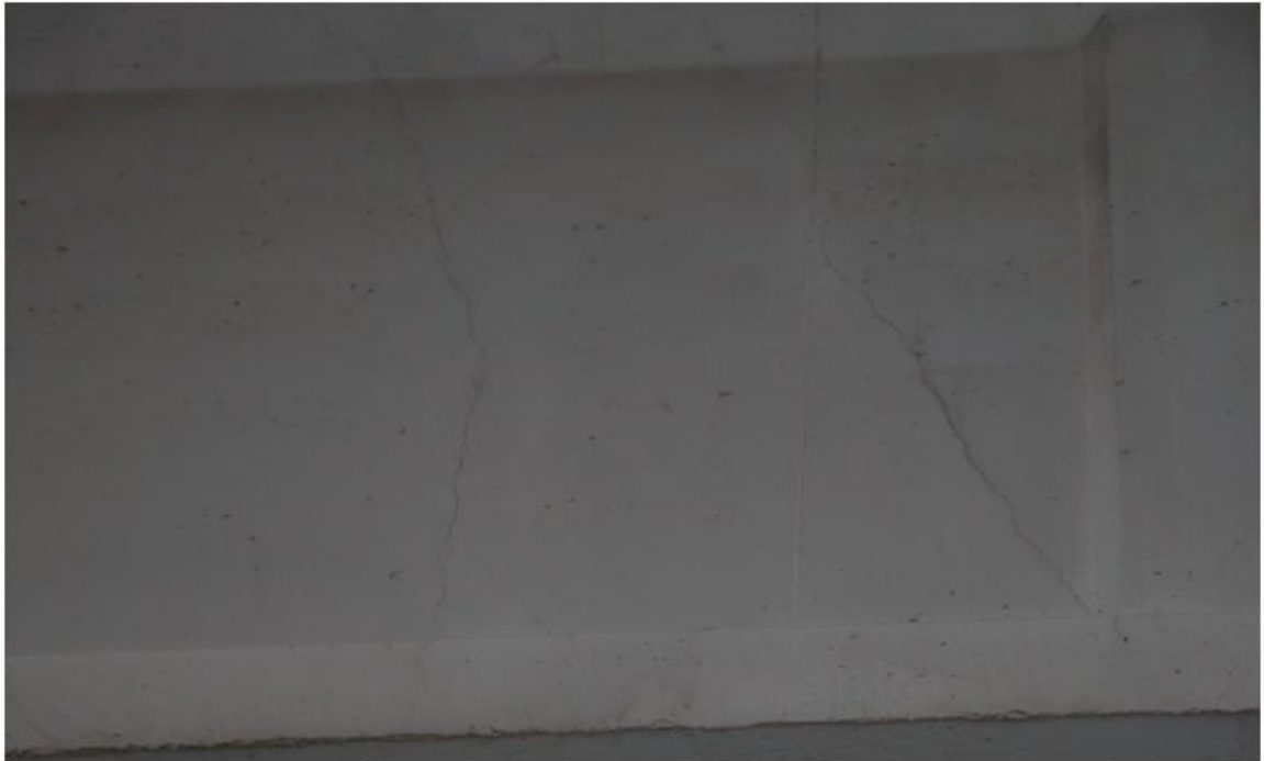
Figura 14. Fessurazione di taglio inclinata a 45 gradi.
