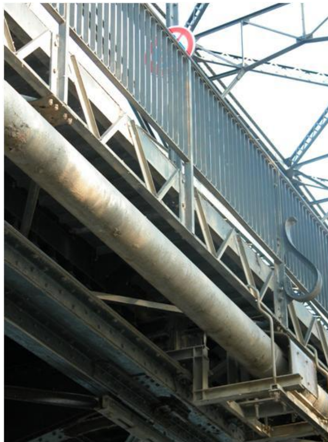
Figura 10. Aggancio inferiore del tirante.
