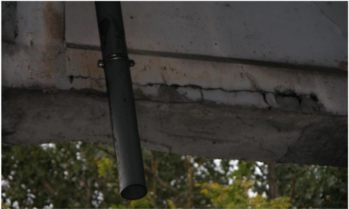
Figura 14. Distacco di copri ferro e corrosione dell'armatura della soletta.
