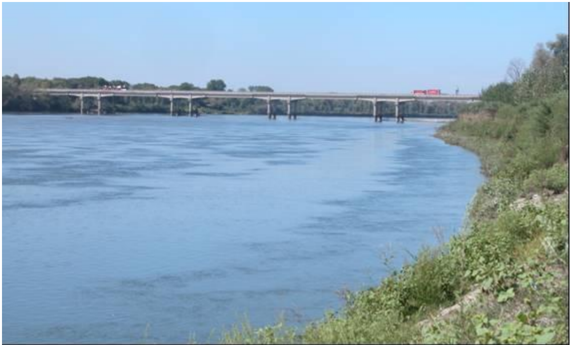
Figura 3. Vista da valle, sponda sinistra.
