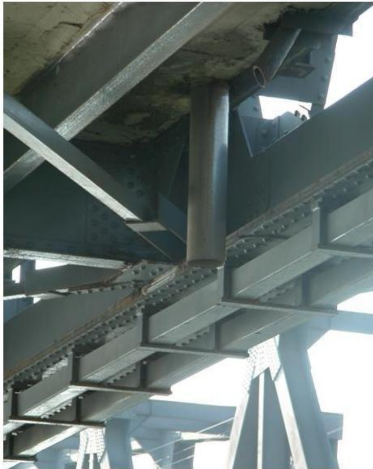
Figura 10. Scrostamento della vernice e corrosione dell'elemento.
