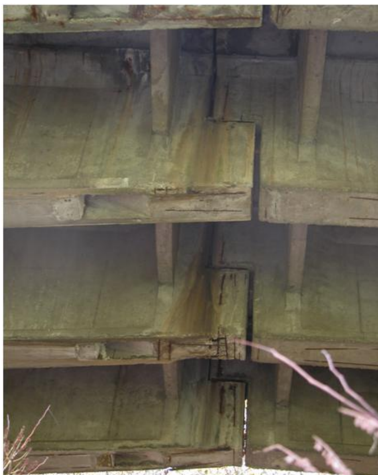
Figura 12. Degrado sulla sella Gerber.
