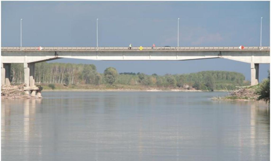
Figura 4. Ingrandimento di una campata con pile e mensole.
