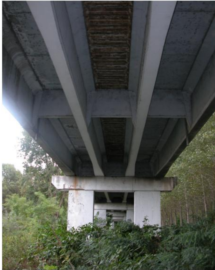
Figura 7. Viadotto di accesso.
