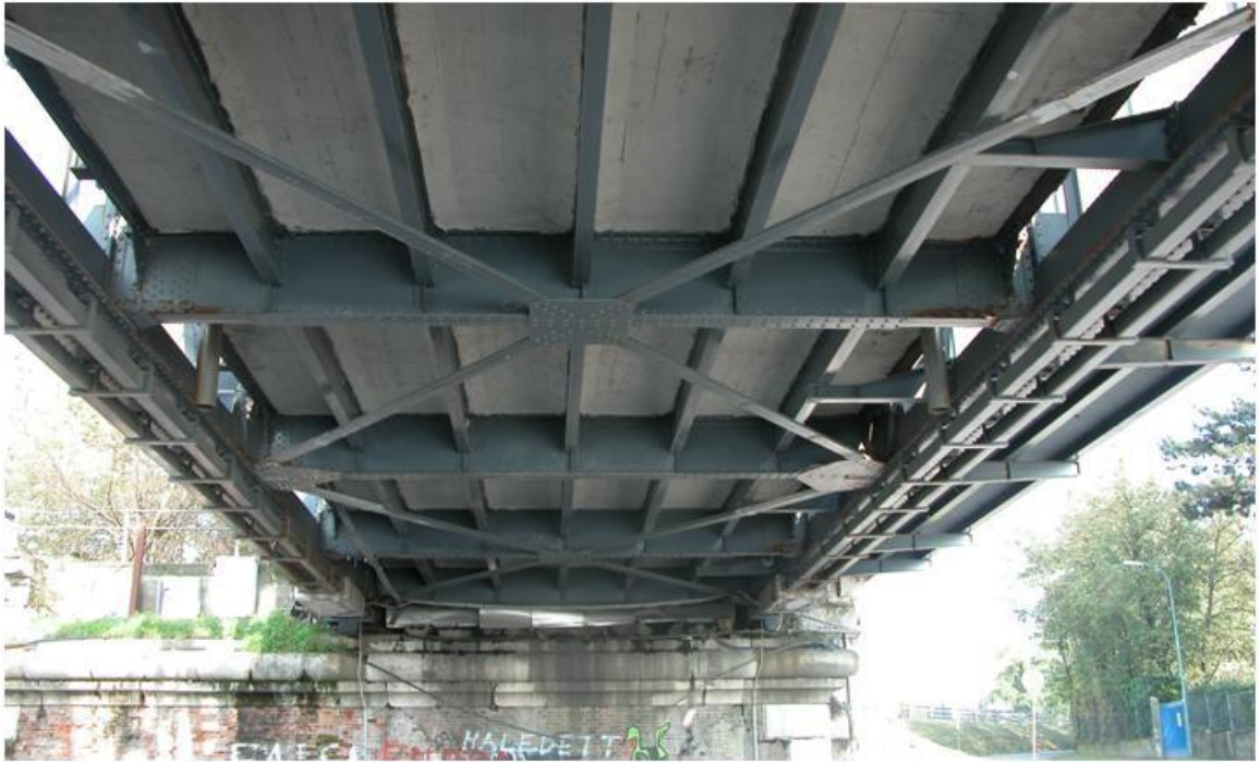
Figura 5. Impalcato del ponte stradale.
