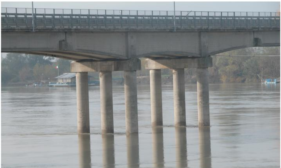
Figura 4. Ingrandimento delle pile in alveo e dei cantilever.
