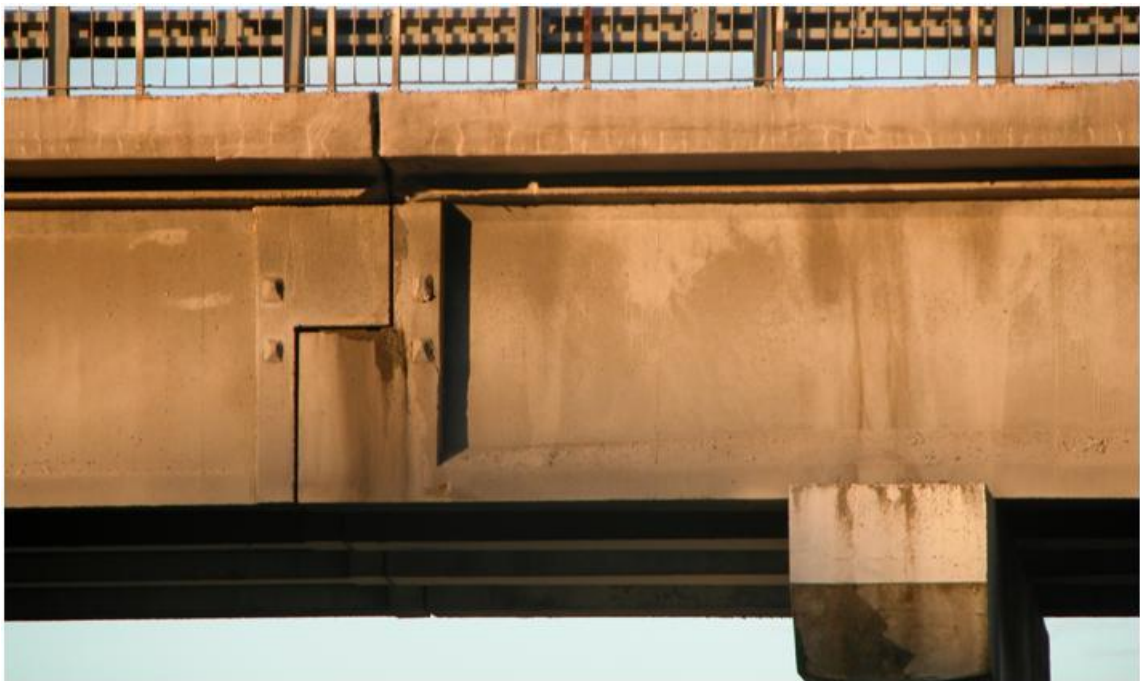
Figura 8. Particolare dell'appoggio delle travi di campata
