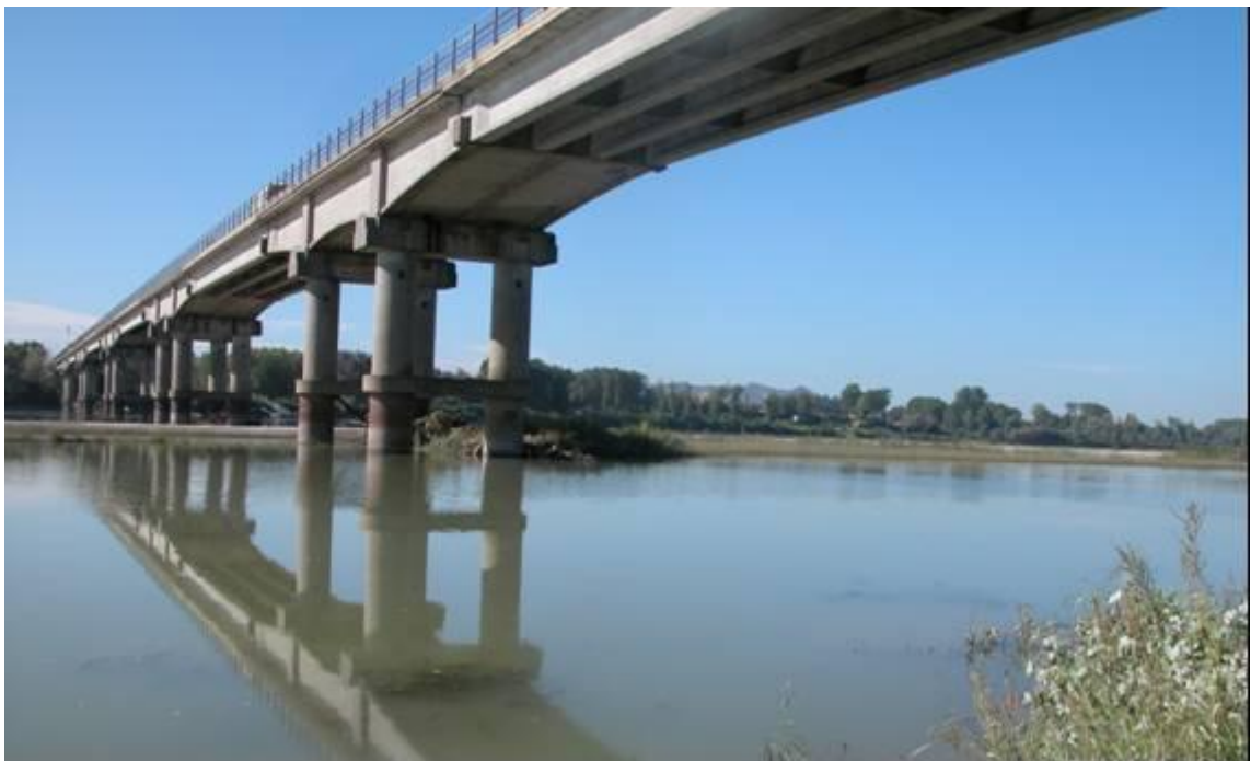
Figura 6. Pile e mensole in alveo.
