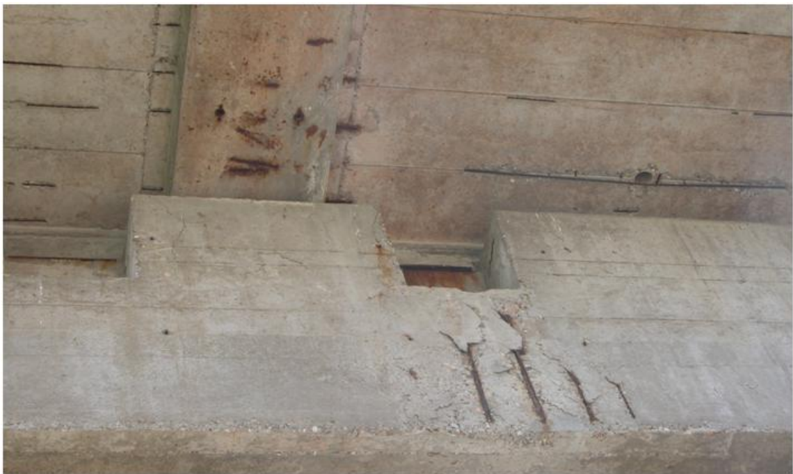
Figura 10. Leggeri distacchi di copriferro.
