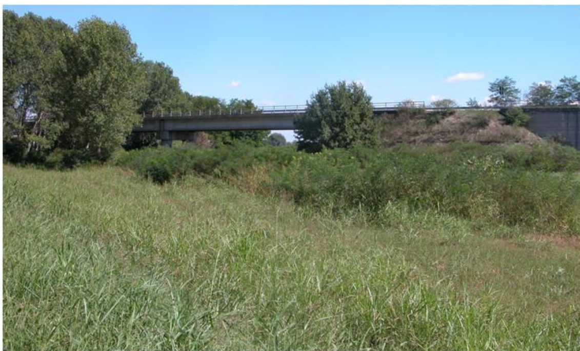
Figura 16. Viadotto e rilevati di accesso al ponte.
