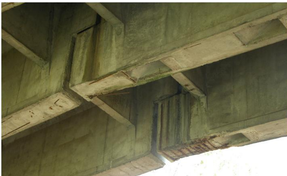
Figura 11. Degrado sulla sella Gerber.
