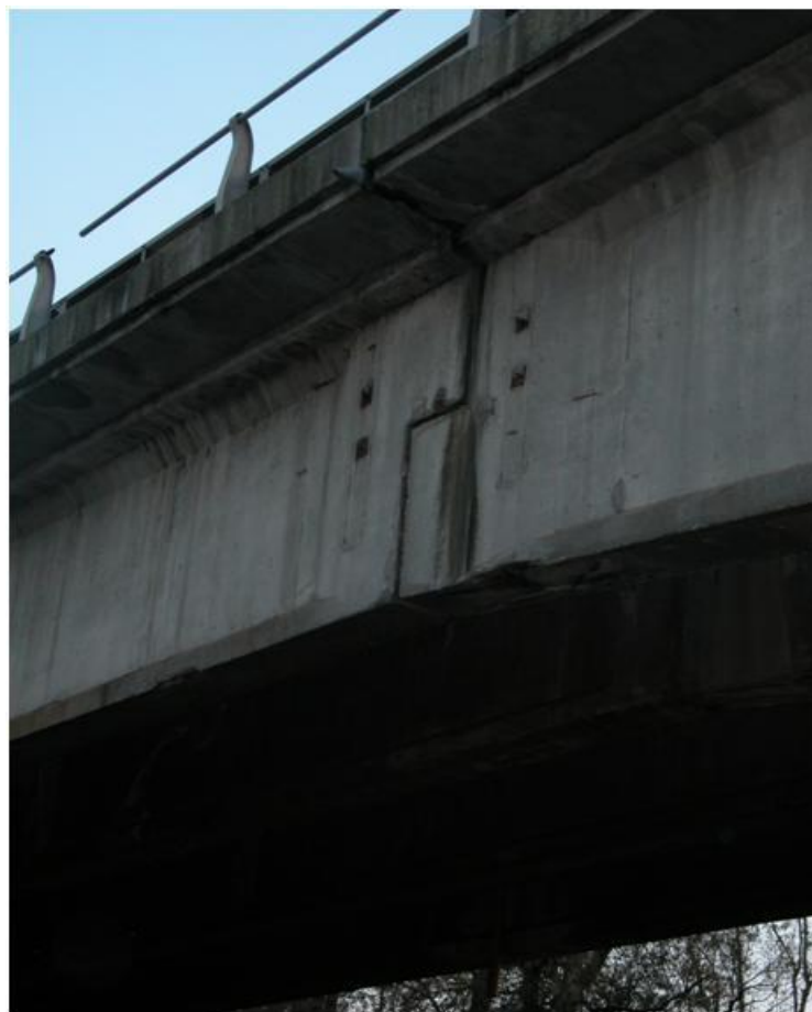
Figura 12. Testate di ancoraggio della precompressione trasversale scoperte in molti punti. Degrado sulla sella Gerber.
