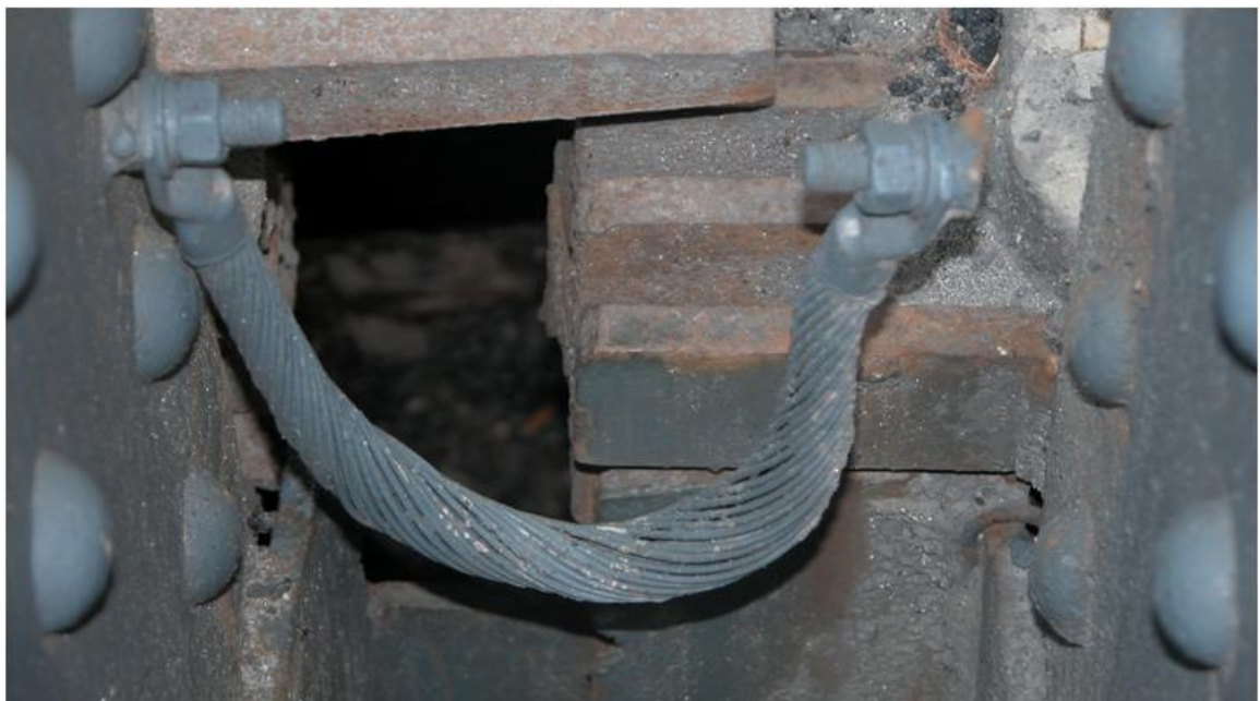
Figura 14. Distacco di un cavo di messa a terra.
