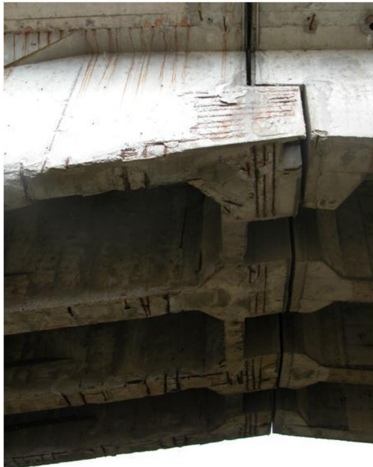
Figura 11. Segni di percolazione di acqua che filtra all'interno della soletta.
