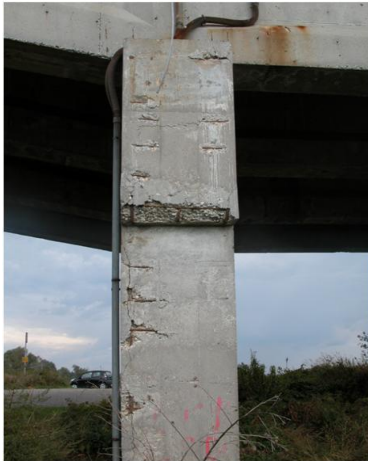
Figura 9. Distacco di copri ferro e corrosione sulle mensole tozze.
