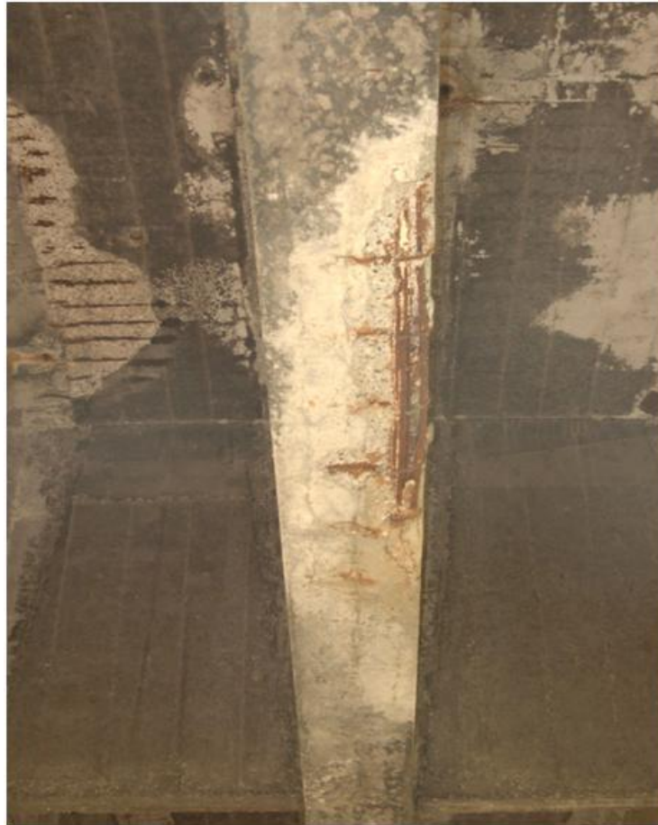
Figura 13. Probabile corrosione interna ad un cavo di precompressione.
