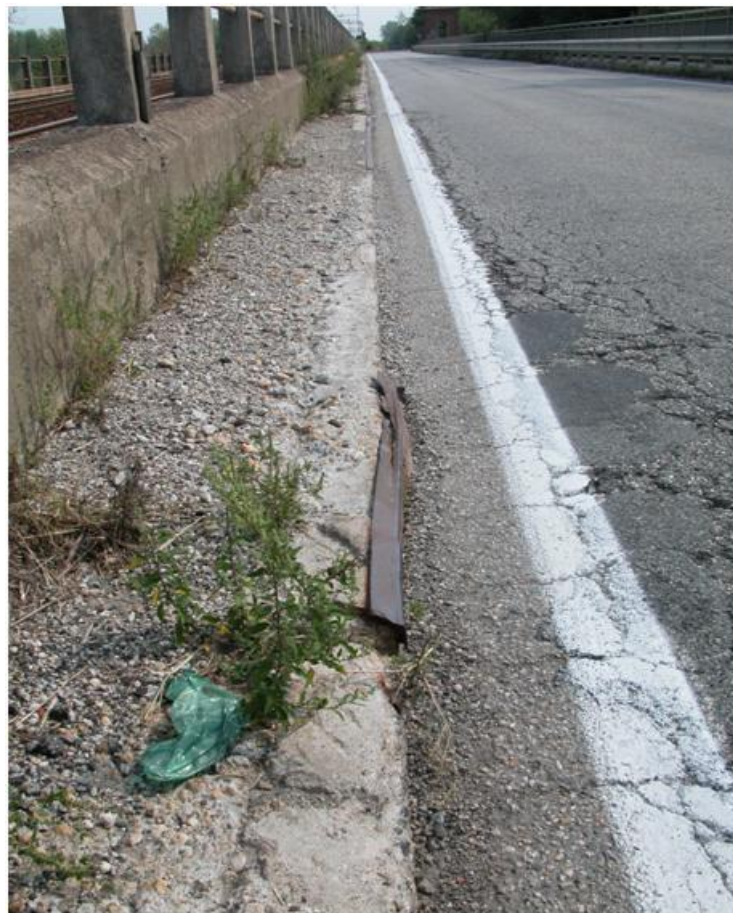
Figura 14 - Particolare della linea di separazione tra il ponte stradale e il ponte ferroviario.
