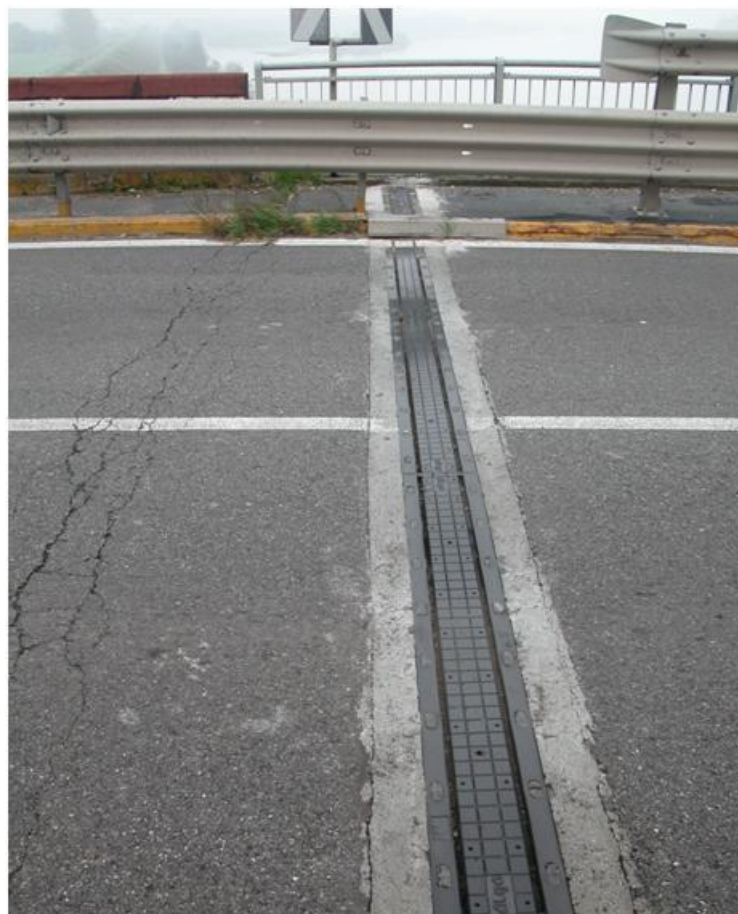
Figura 10. Particolare di un giunto.
