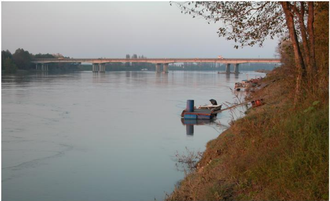
Figura 3. Vista da monte, sponda destra (le pile sulla destra sono state rinforzate).
