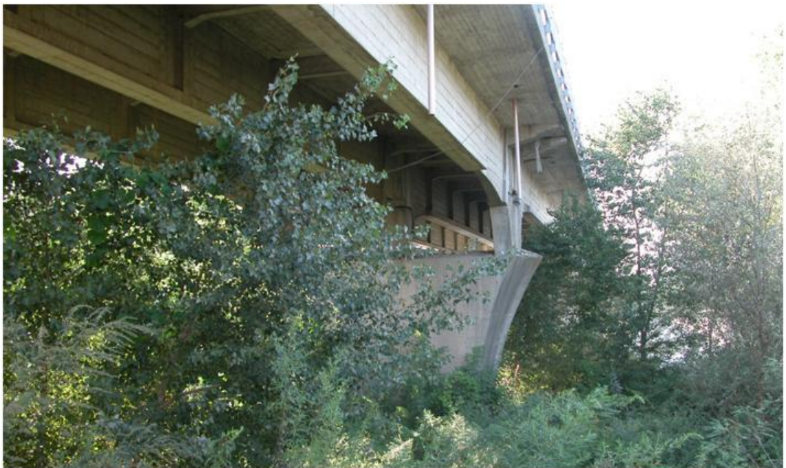
Figura 6. Vista delle tre travi di campata del ponte e dei tubi di drenaggio.
