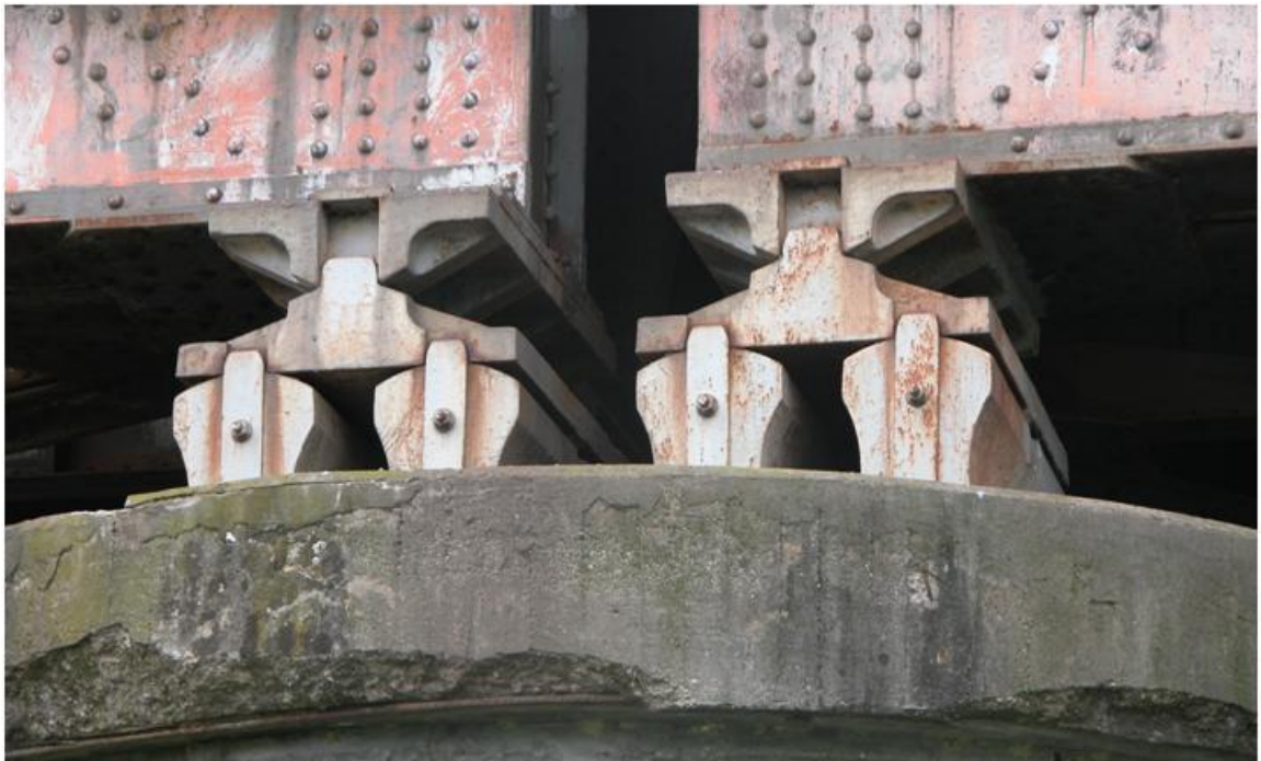
Figura 7. Particolare del meccanismo dei carrelli di appoggio.
