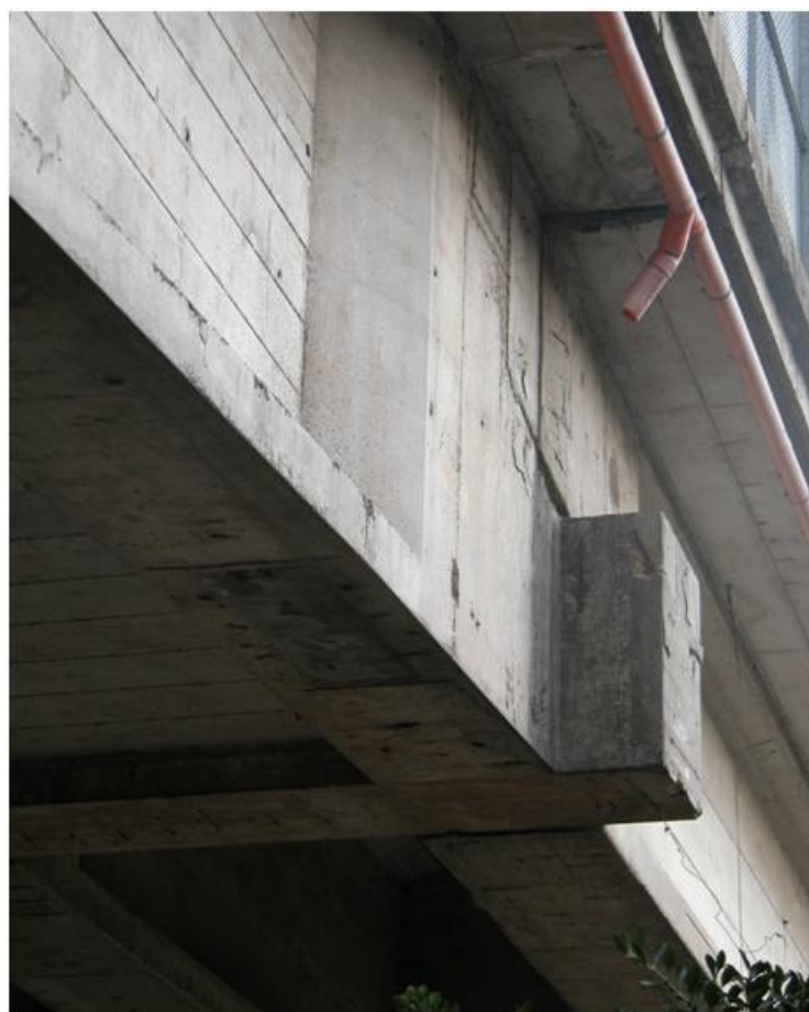
Figura 12. Posizionamento del pluviale di scarico (intervento recente) in direzione della sella Gerber.
