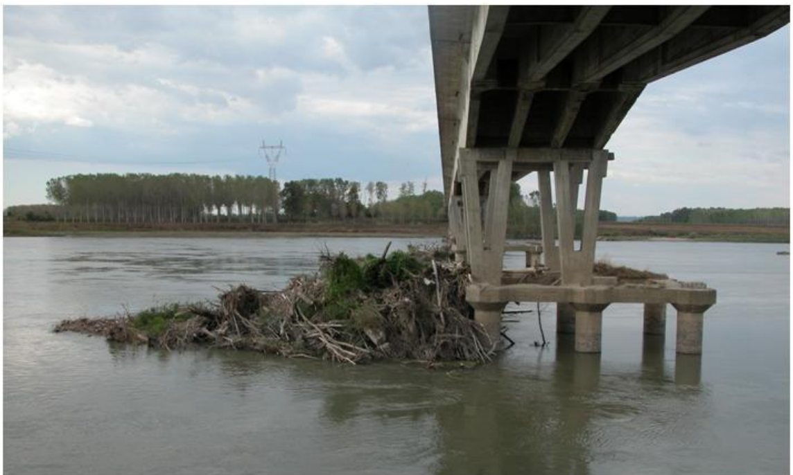
Figura 5. Pila in alveo con ramaglie.
