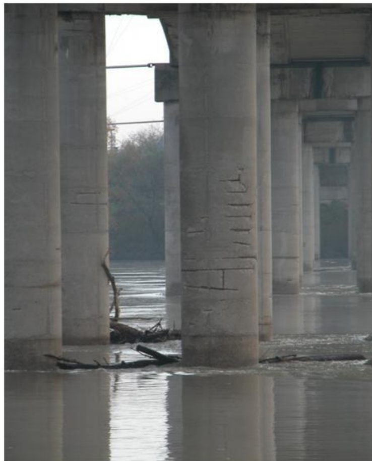
Figura 14. Particolare della corrosione su alcune armature delle pile.
