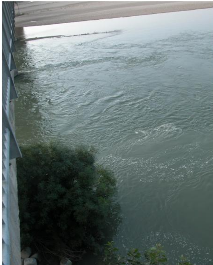
Figura 12. Corrente a valle delle pile. Anche se il fiume non è a regime si nota la formazione di numerosi vortici.
