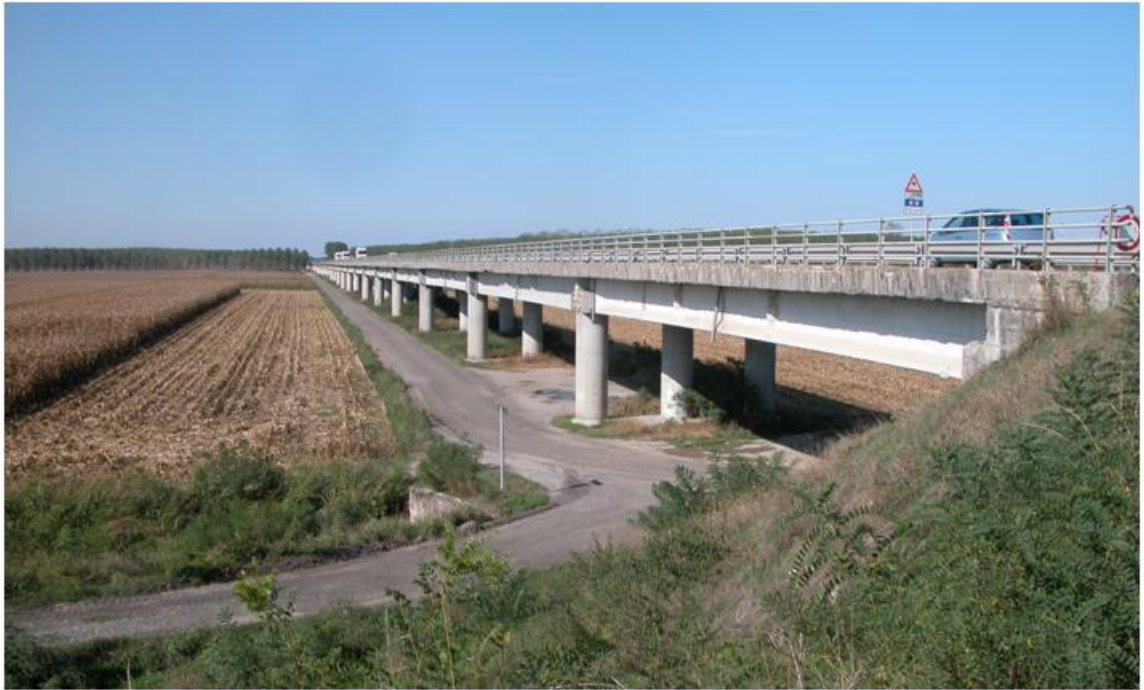
Figura 9. Viadotto di accesso.
