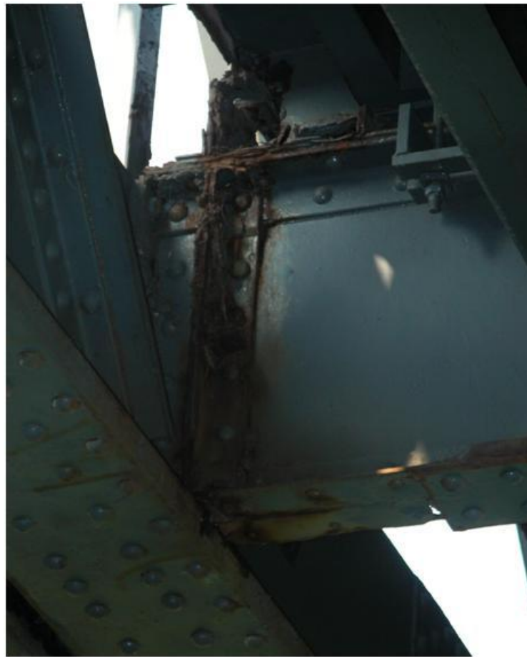
Figura 14. Distacco di un cavo di messa a terra.
