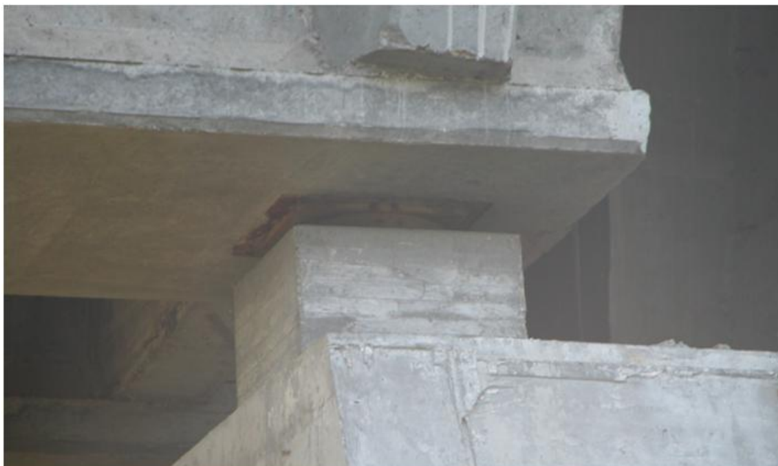
Figura 16. Particolare dell'appoggio.
