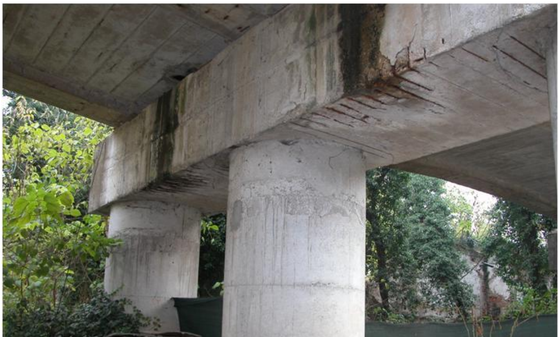
Figura 8. Distacco del copriferro e corrosione sui pulvini.
