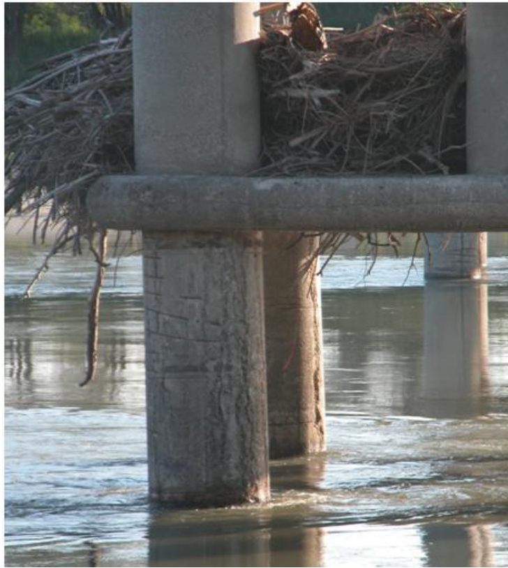
Figura 6. Mensole di appoggio con armature scoperte.
