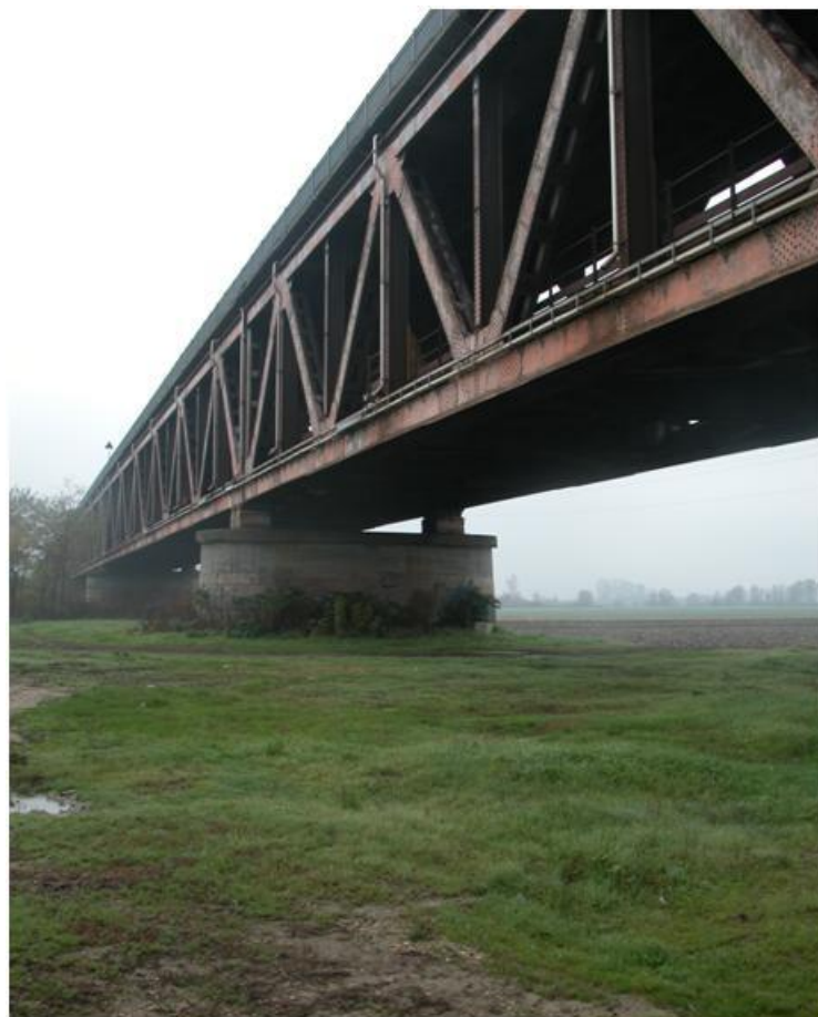
Figura 4. Tralicciatura della trave in acciaio.
