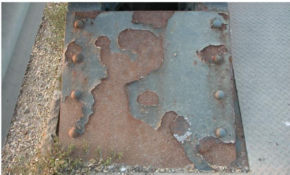
Figura 12. Tracce di corrosione.
