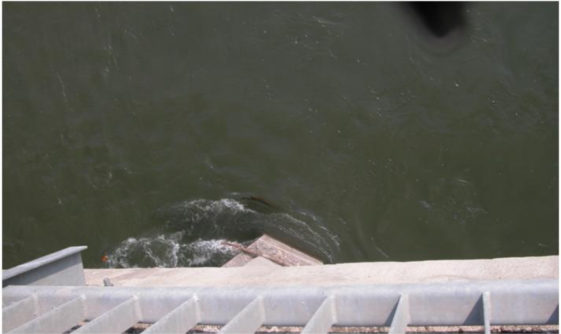
Figura 12. Corrente a valle delle pile. Anche se il fiume non è a regime si nota la formazione di numerosi vortici.
