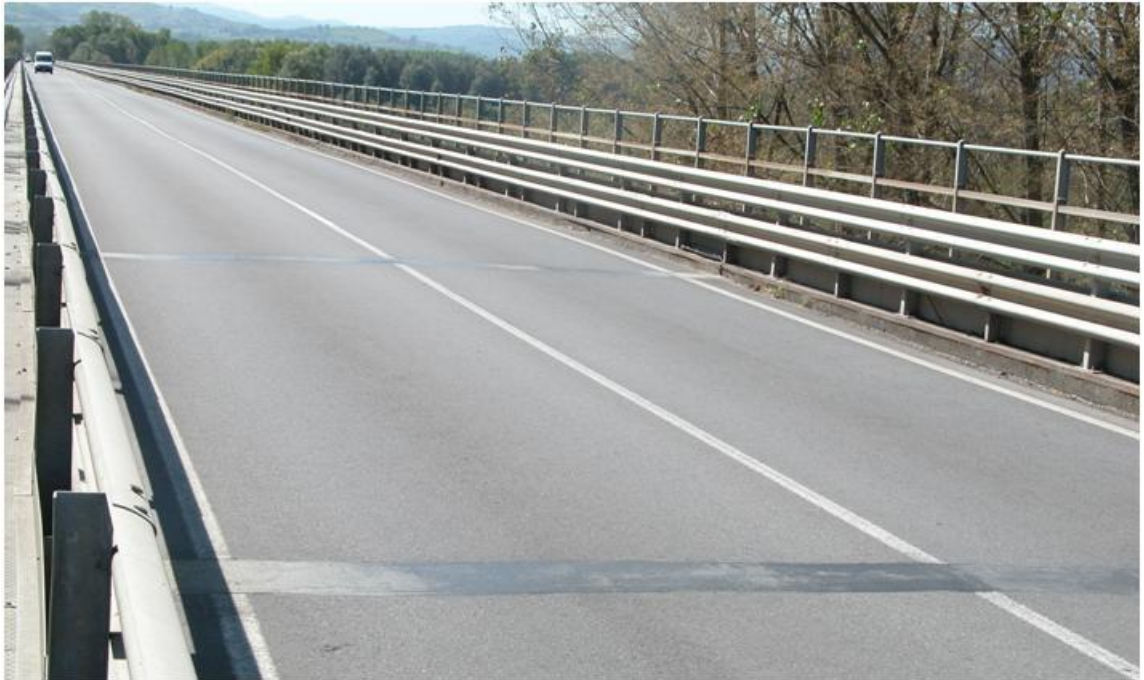
Figura 8. Giunto di dilatazione.
