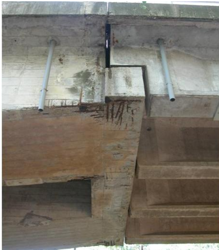
Figura 6. Mensole di appoggio con armature scoperte.
