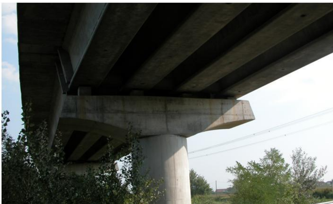
Figura 15. Particolare delle quattro travi di campata del viadotto e del loro arrivo sulla pila.
