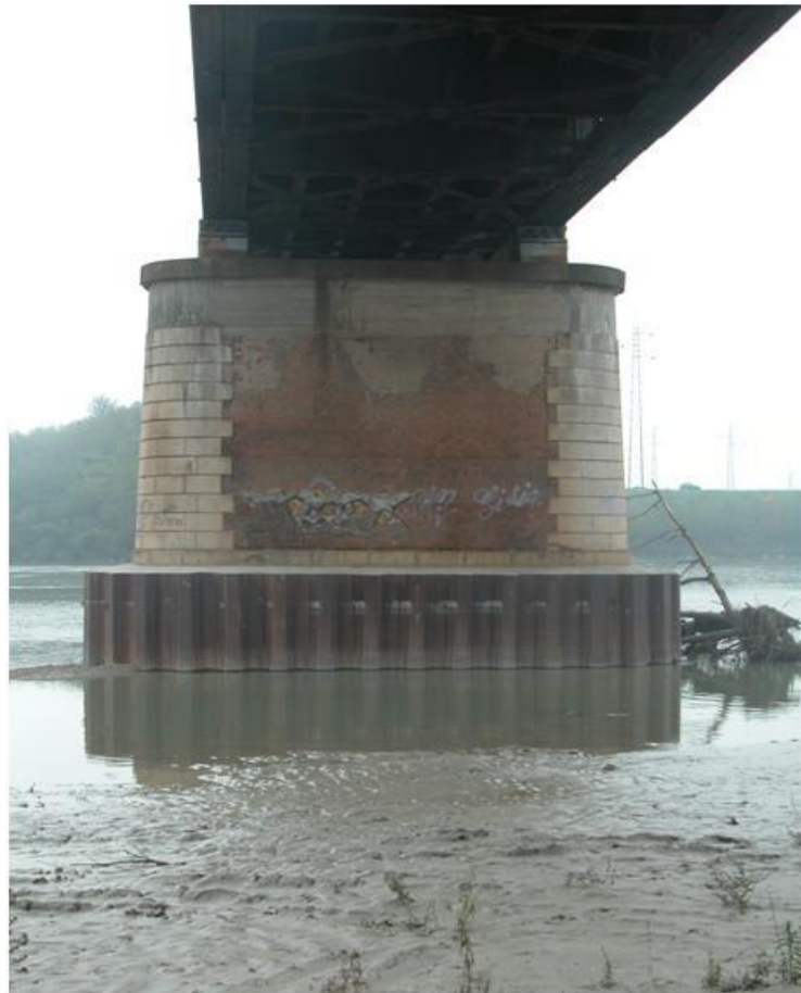
Figura 12. Particolare di una pila in alveo.
