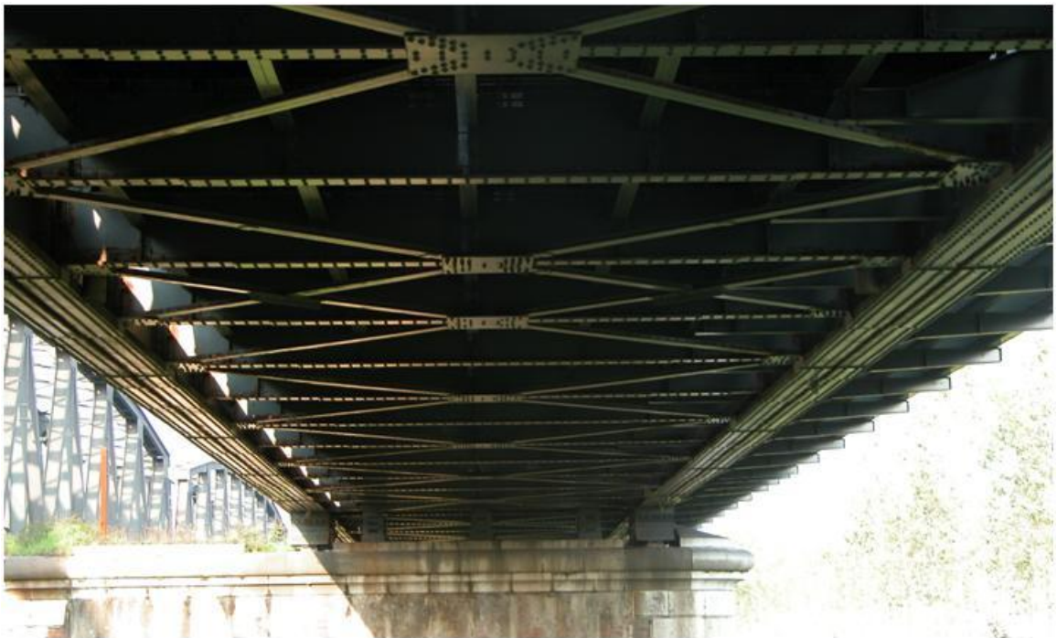
Figura 6. Impalcato del ponte ferroviario.
