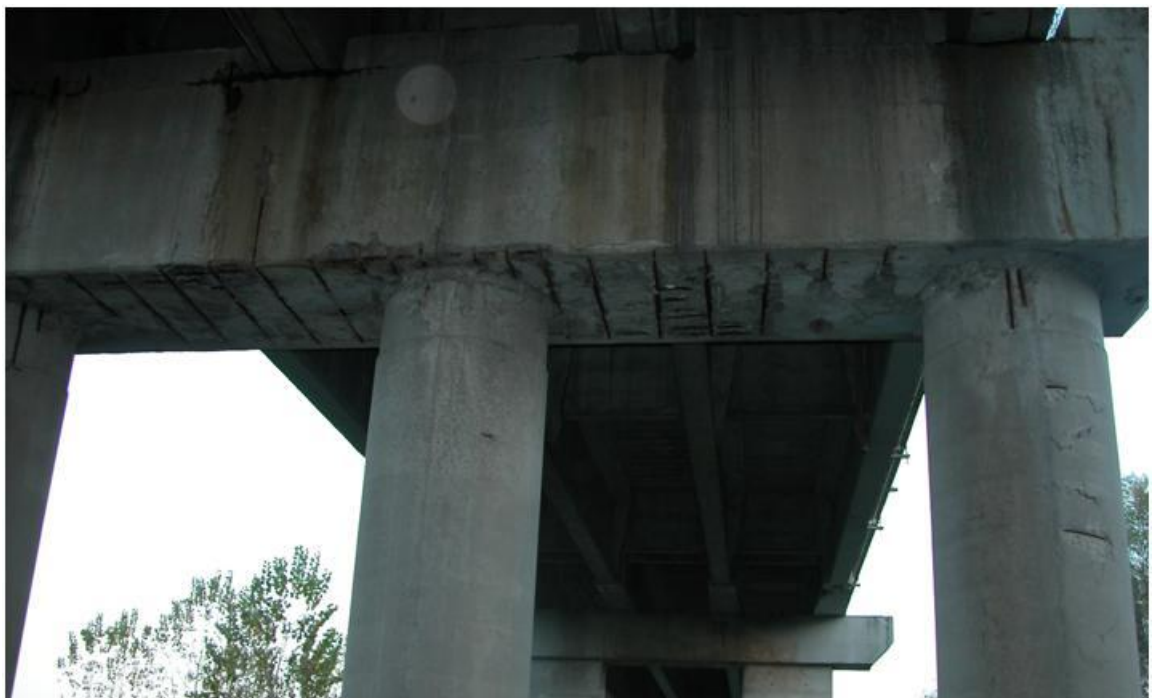
Figura 12. Testate di ancoraggio della precompressione trasversale scoperte in molti punti. Degrado sulla sella Gerber.
