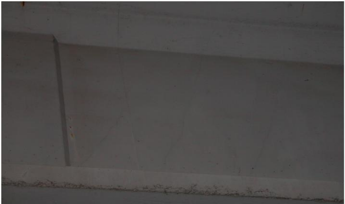
Figura 14. Fessurazione di taglio inclinata a 45 gradi.
