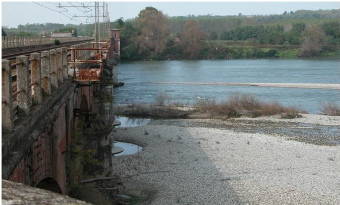
Figura 8 - Vista del fiume lato monte. Si noti la modesta presenza di ramaglie fermate dalle pile e l'erosione attorno ad esse visibile nella zona in secca.
