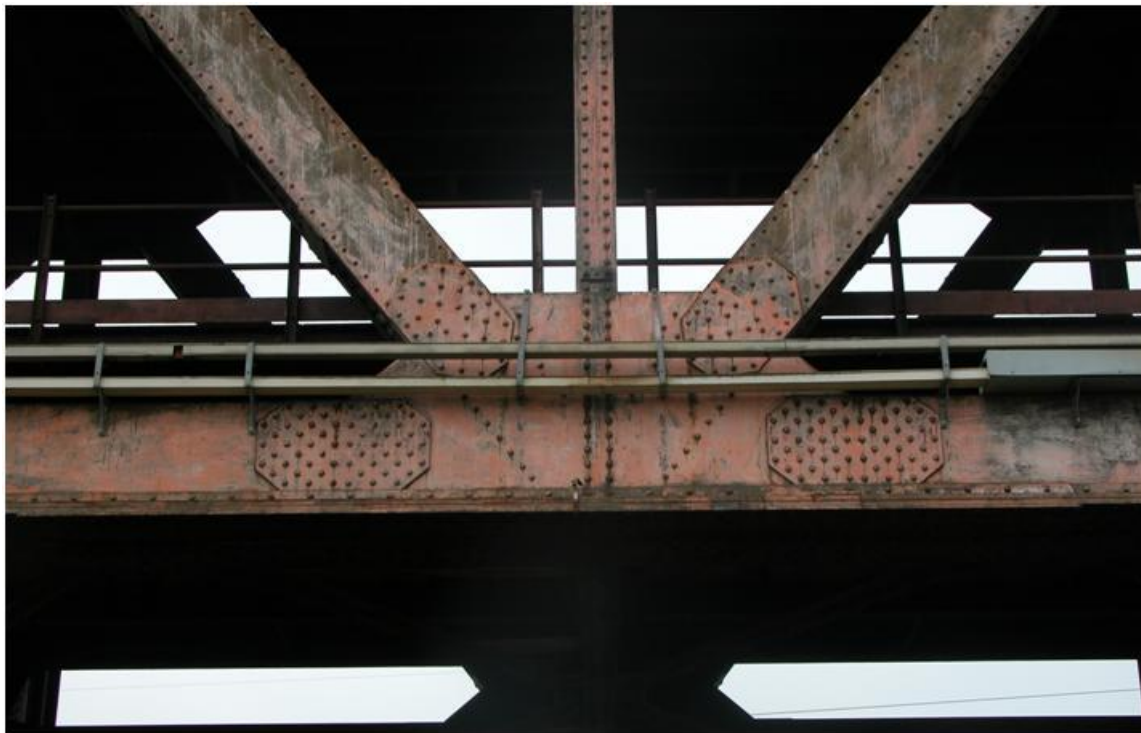
Figura 5. Particolare di un nodo chiodato.
