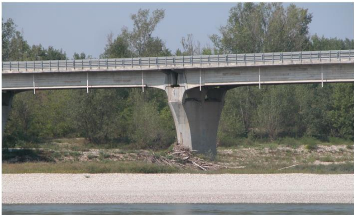
Figura 4. Particolare dell'appoggio sulla pila delle travi e dell'accumulo di ramaglie contro la pila.
