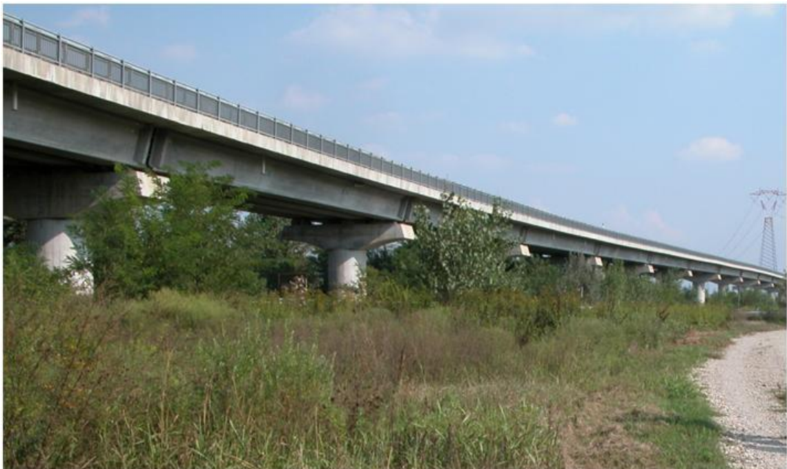
Figura 14. Viadotto di accesso al ponte, vista dal piano di campagna.
