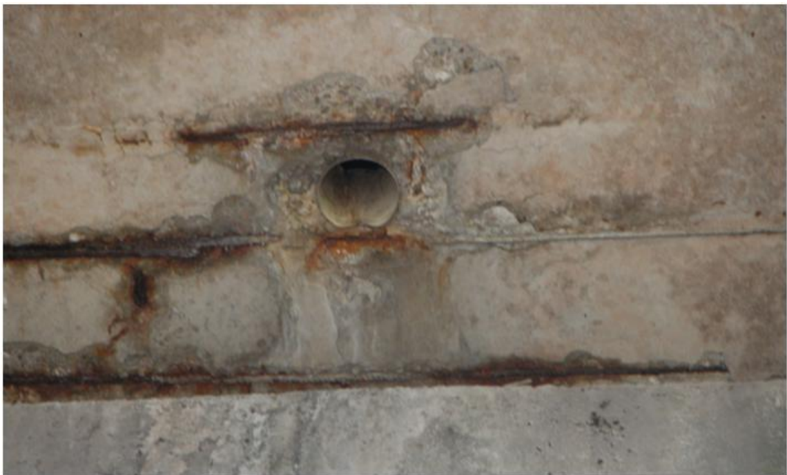
Figura 12. Mancanza dei tubi di scolo e corrosione attorno al foro di drenaggio.
