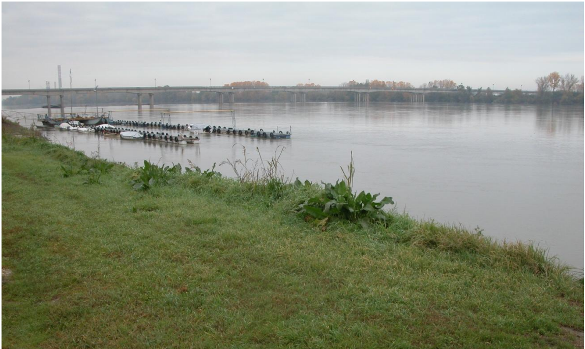
Figura 3. Vista da monte, sponda sinistra.
