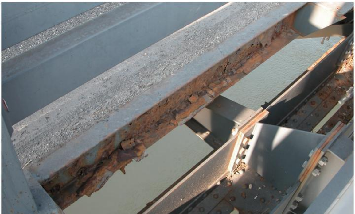
Figura 12. Scrostamento della vernice e corrosione dell'elemento.
