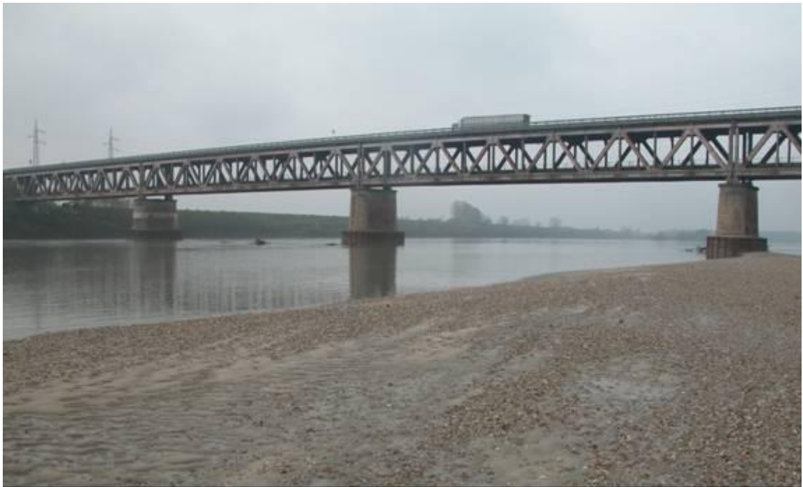
Figura 3. Vista da valle, sponda sinistra.
