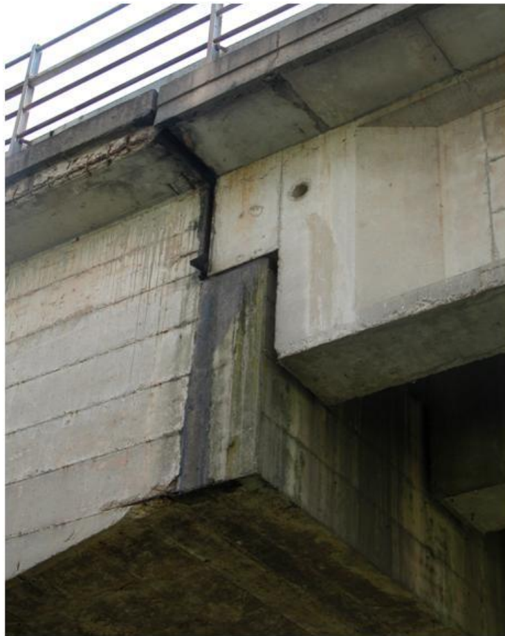
Figura 12. Mancanza dei tubi di scolo e corrosione attorno al foro di drenaggio.
