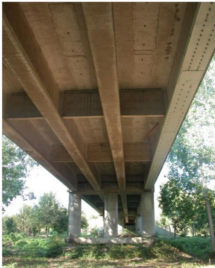
Figura 8. Alcune travi del ponte sono state rinforzate tramite l'applicazione di piastre in acciaio.
