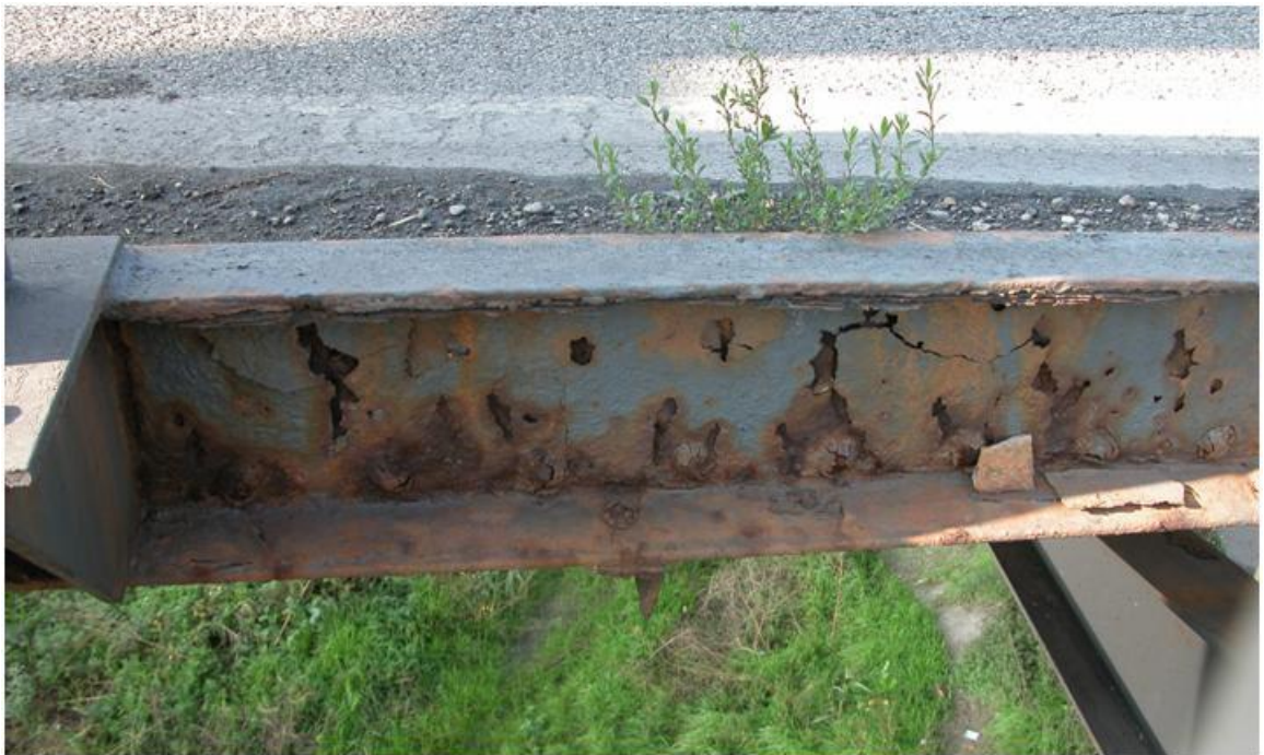
Figura 12. Scrostamento della vernice e corrosione dell'elemento.
