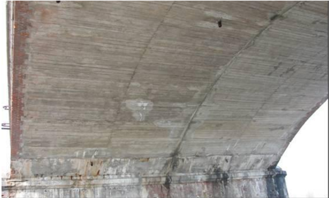
Figura 14 - Particolare della linea di separazione tra il ponte stradale e il ponte ferroviario.
