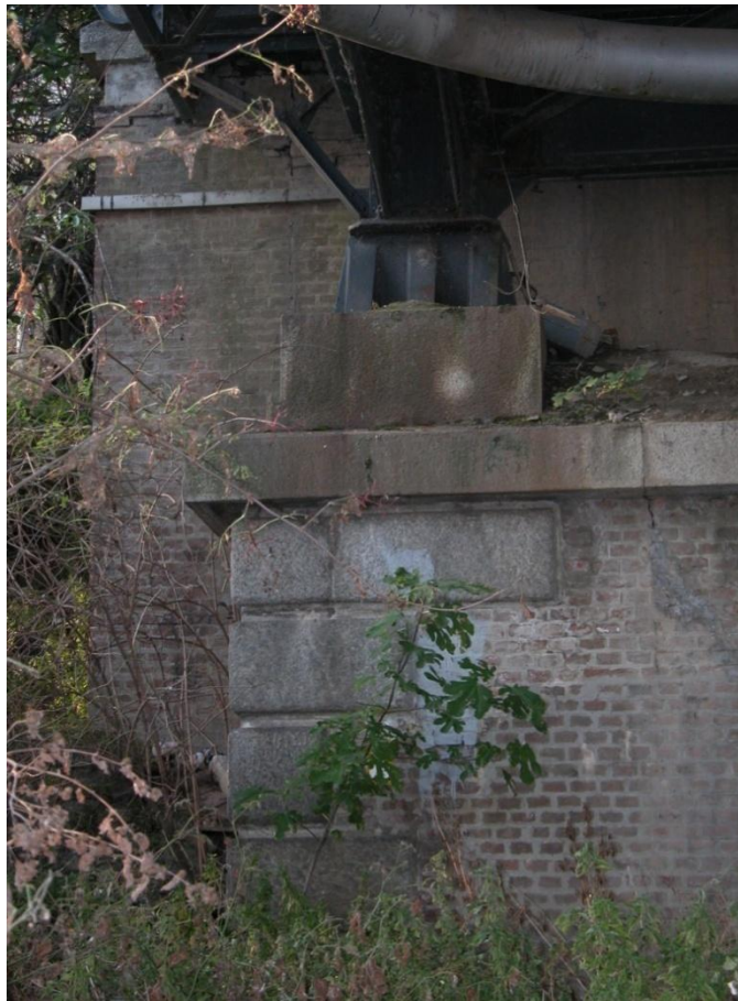
Figura 5. Appoggio sulla spalla della prima campata.
