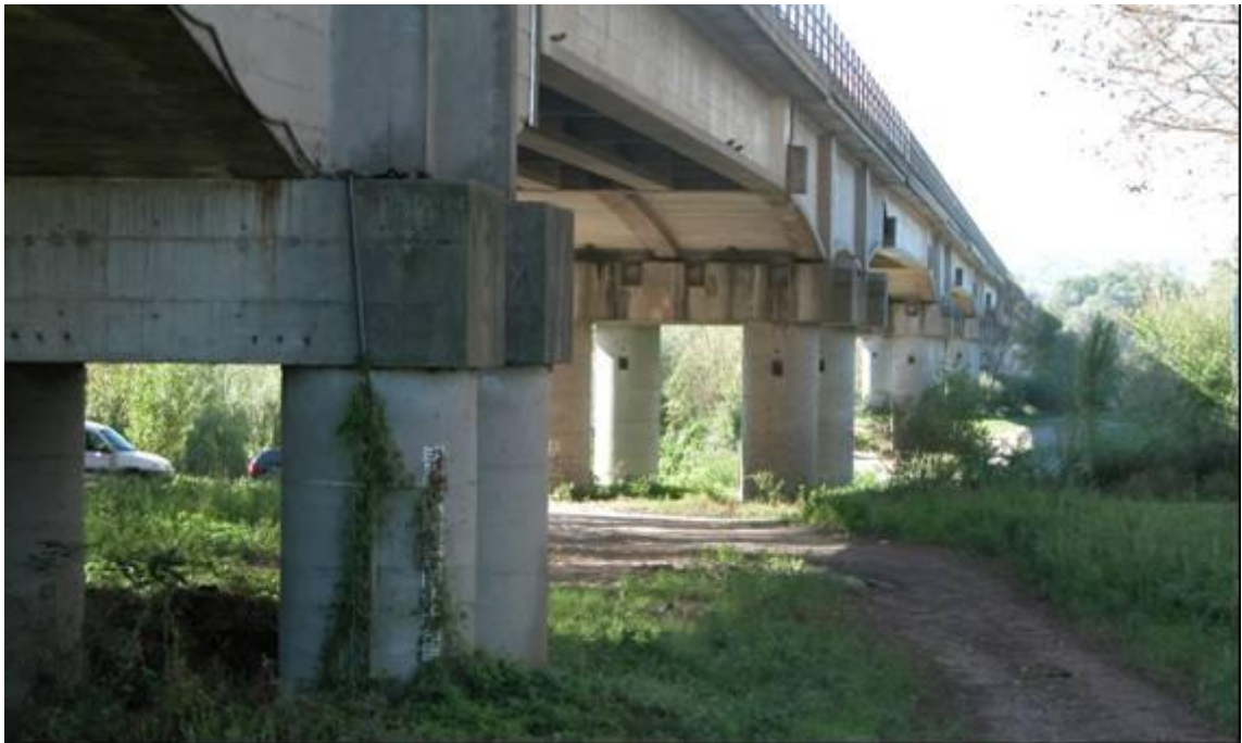
Figura 5. Pile e mensole in golena.
