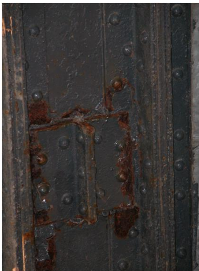
Figura 12. Tracce di corrosione.
