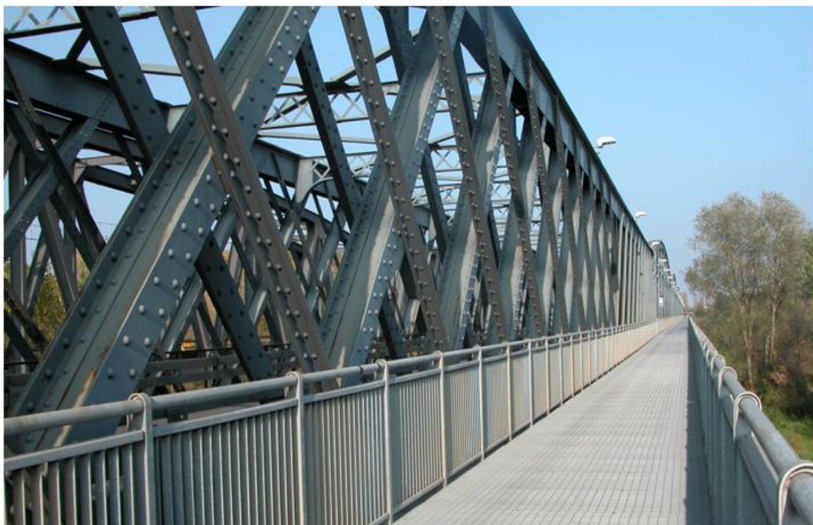
Figura 7. Vista del viadotto d'ingresso (officine Savigliano, 1892) e del ponte sul po (officine ILVA, 1948).
