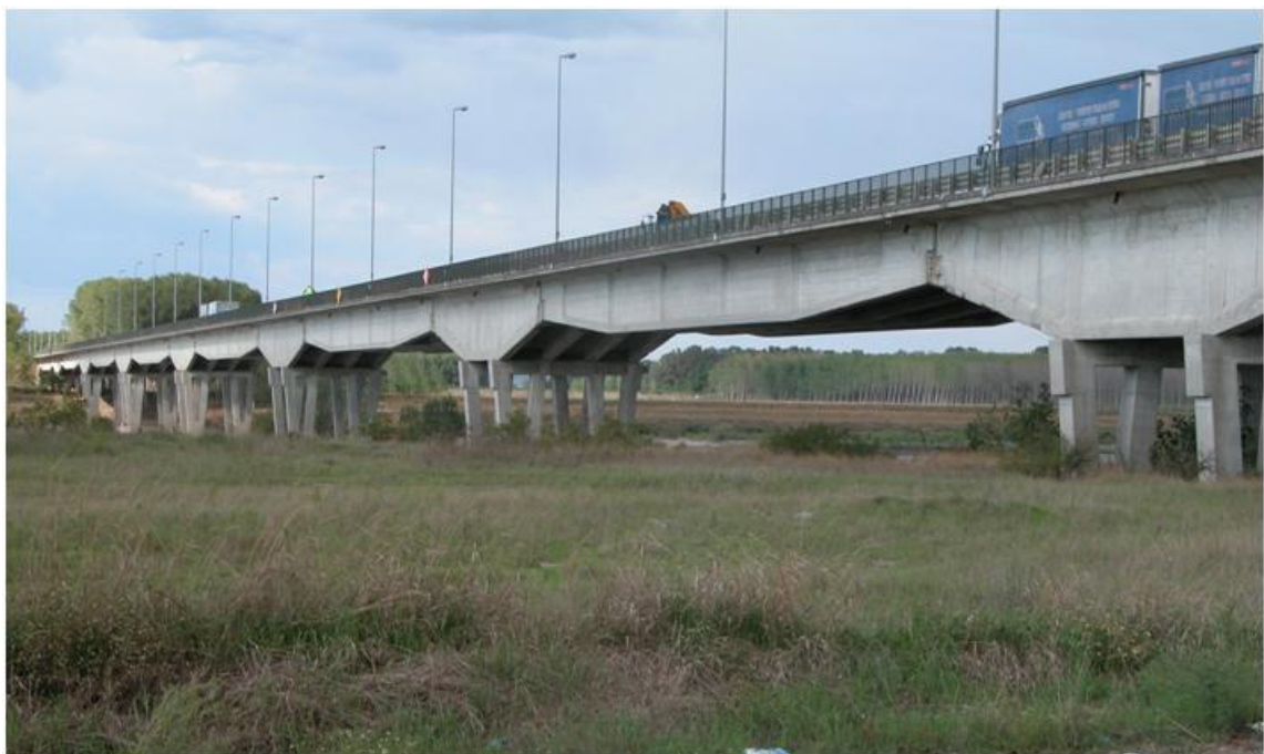
Figura 7. Viadotto di accesso.
