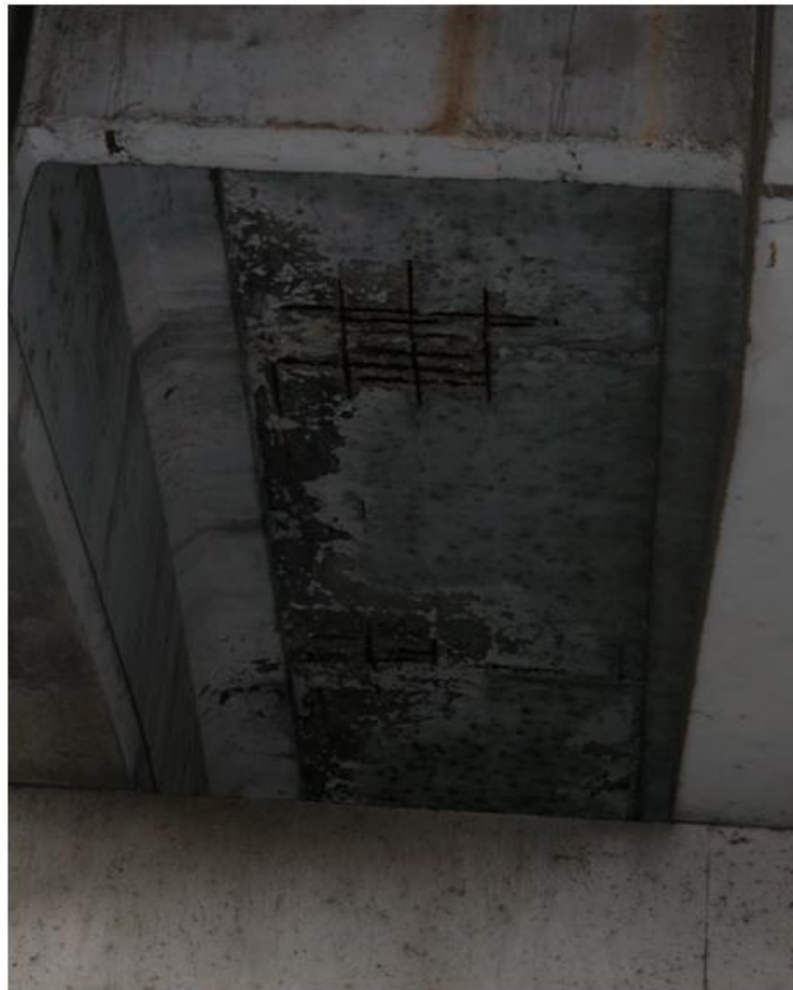
Figura 14. Distacco di copri ferro e corrosione dell'armatura della soletta.
