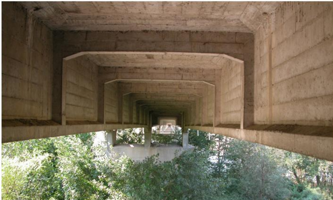
Figura 7. Vista dei traversi d'unione delle travi di campata.
