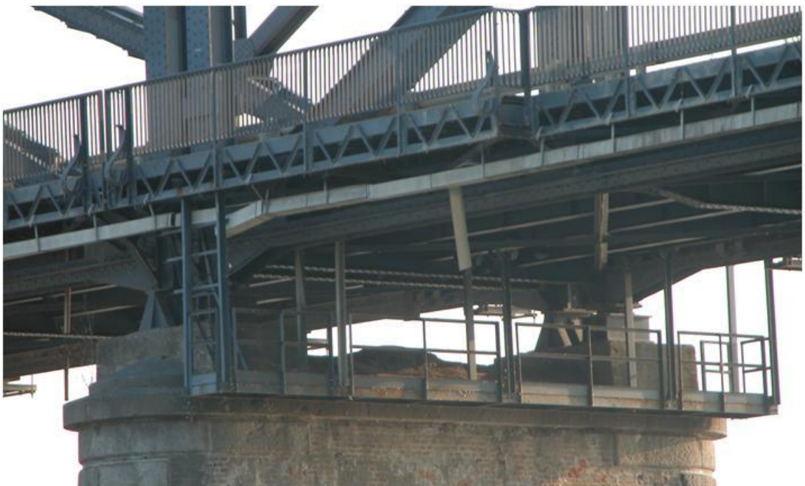
Figura 6. Appoggio sulla pila di una campata intermedia.
