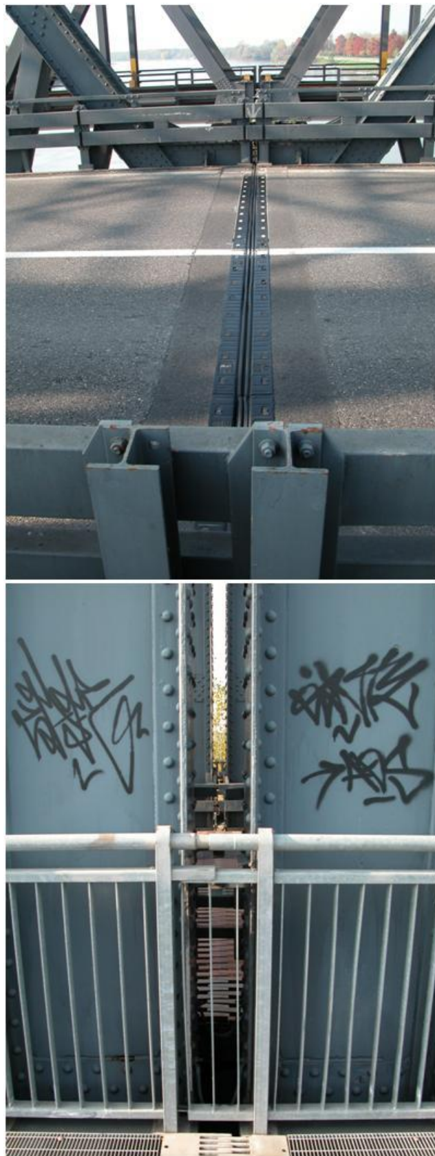
Figura 8. Giunto presente sull'impalcato "Officine ILVA" e giunto presente sull'impalcato "Officine Savigliano"
