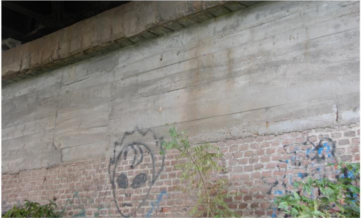
Figura 11. Particolare di una pila del viadotto di ingresso, la parte in basso sembra costruita in muratura, la parte alta in calcestruzzo
