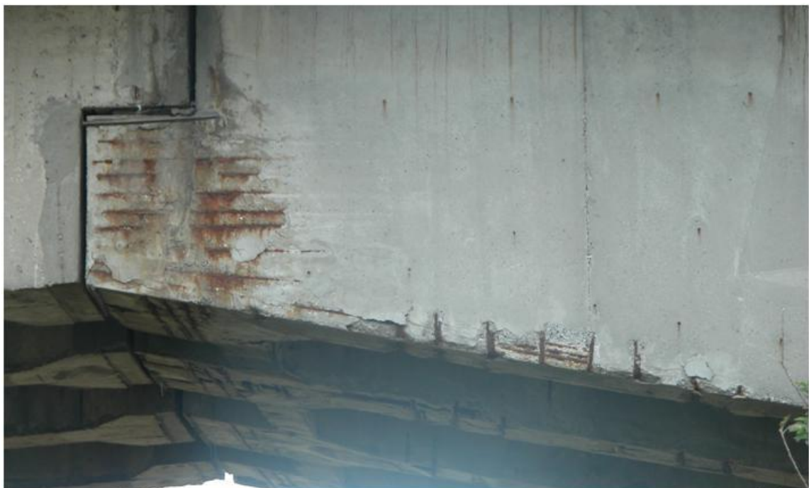
Figura 9. Distacco di copri ferro e corrosione sulle mensole tozze.
