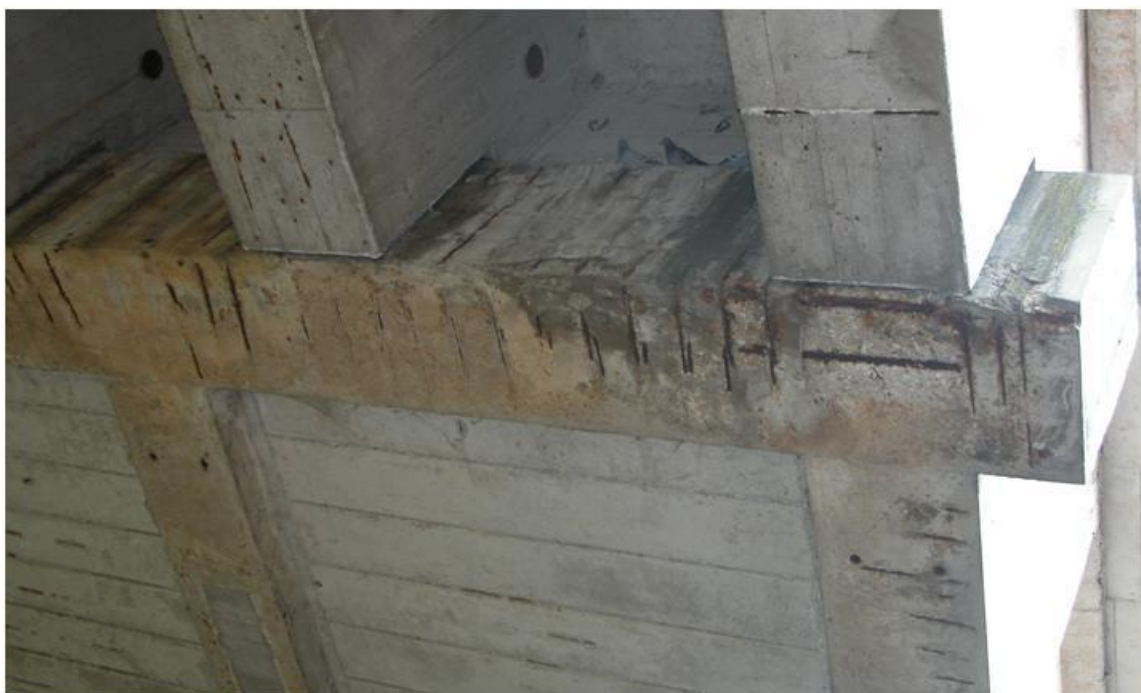
Figura 12. Posizionamento del pluviale di scarico (intervento recente) in direzione della sella Gerber.
