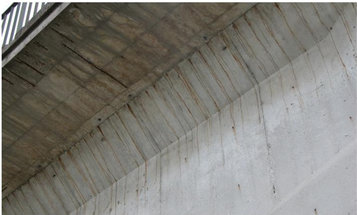
Figura 11. Segni di percolazione di acqua che filtra all'interno della soletta.
