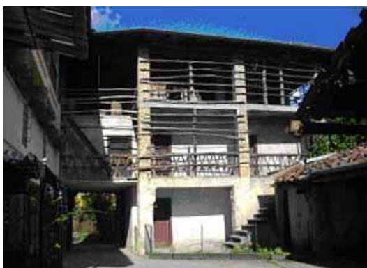
Fig. 8. Gandino: Ca’ Parecia, caratteristica corte rurale con la loggia esposta a sud per l’essiccazione dei prodotti
