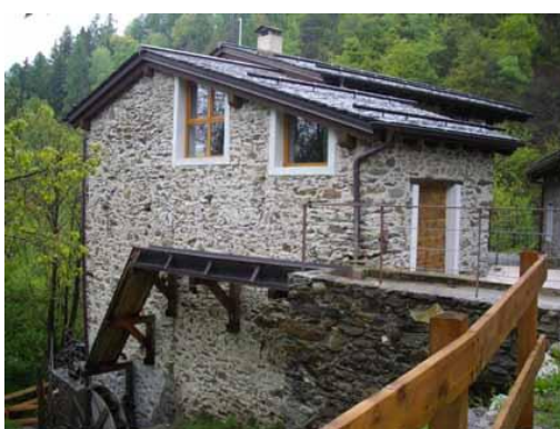
Fig. 12 Negli ampliamenti degli edifici di stabulazione i nuovi materiali vengono messi in opera riprendendo la muratura in pietra a piano terra e i laterizi sflasati nei grigliati delle aperture del fienile al primo piano
