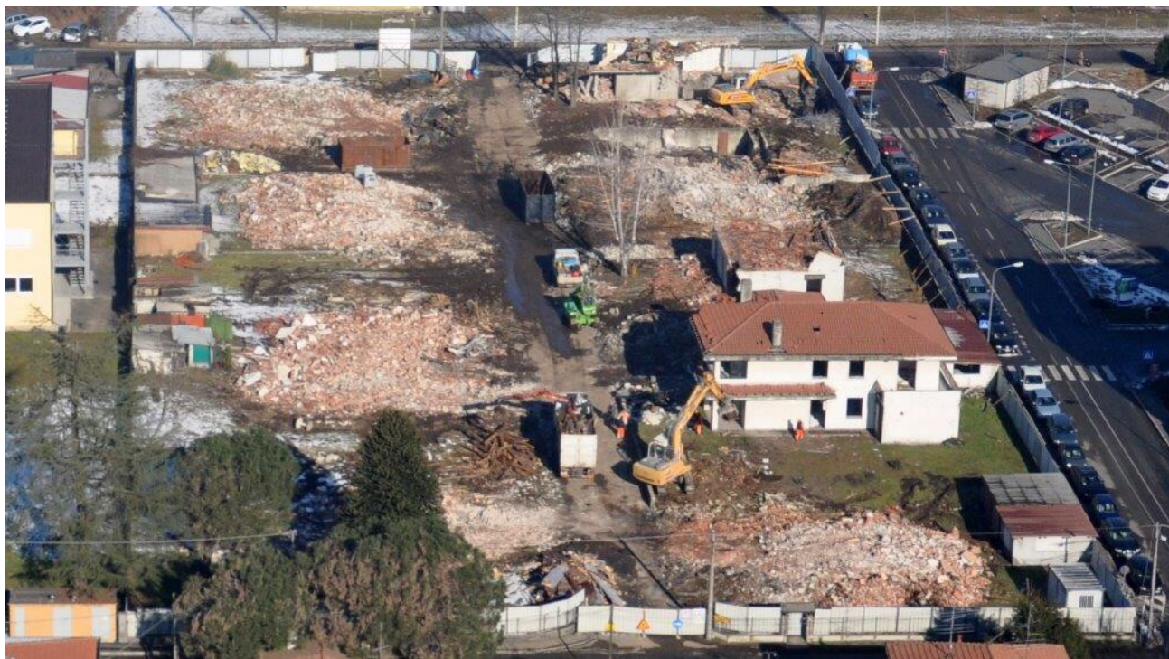
Opere di demolizione nel comparto 30 nel Comune di Somma Lombardo - I fase di demolizione
